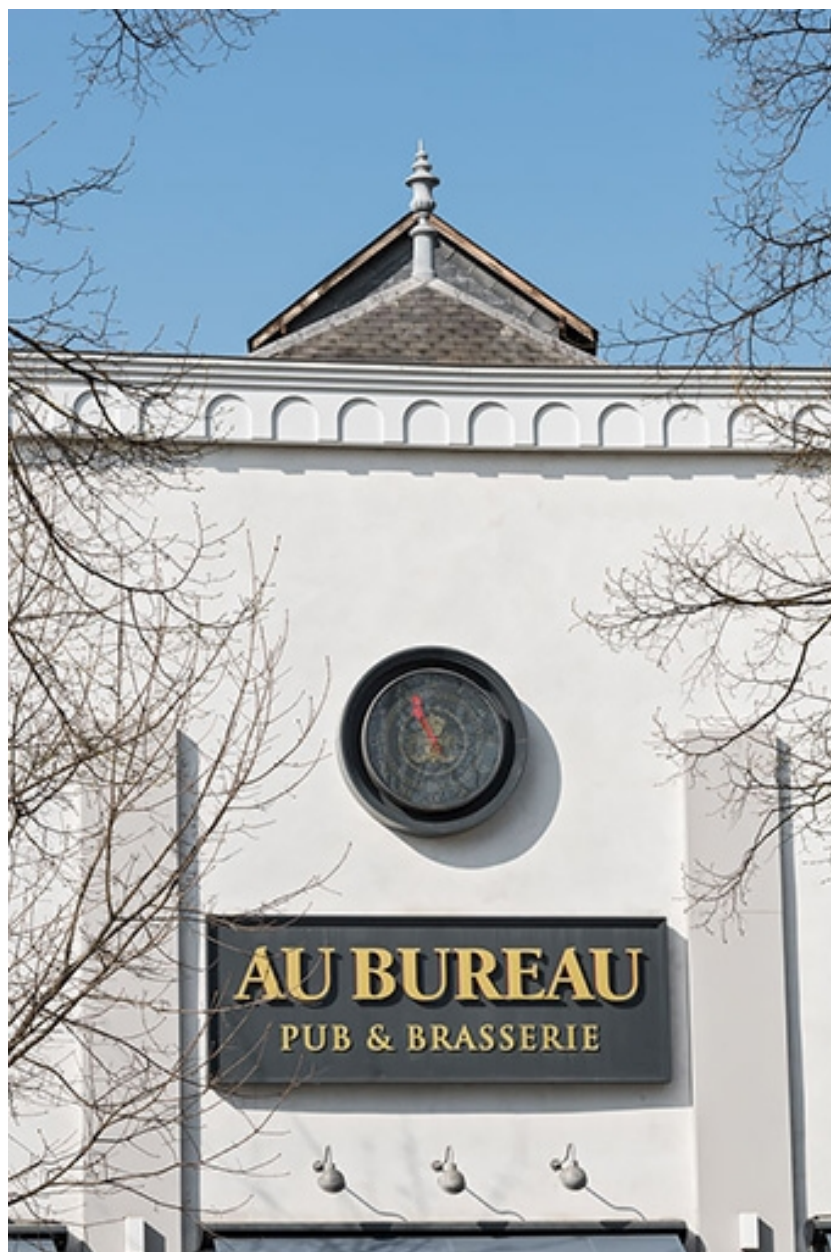
Façade antérieure : décor de la travée centrale.
