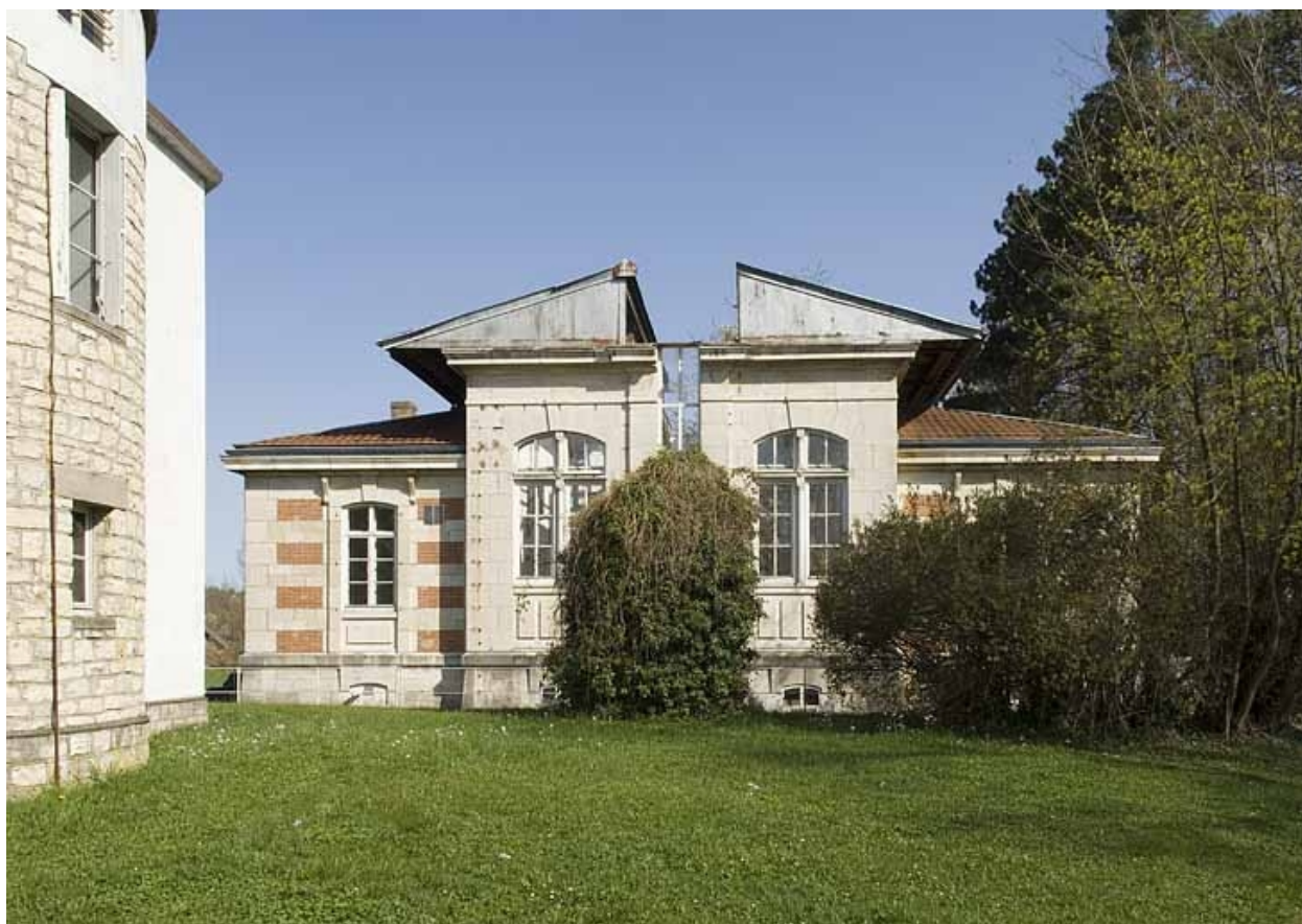
Elévation sud du pavillon, toiture ouverte.
