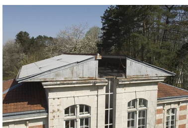
Toiture ouverte. Phot. Jérôme Mongreville IVR43_20092500723NUC2A
