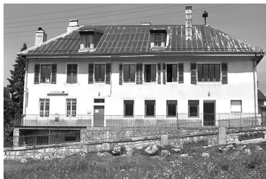
Façade antérieure. Phot. Jérôme Mongreville IVR43_20003900336X
