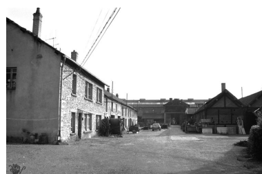
Vue d'ensemble depuis l'entrée en 1987. Phot. Bernard Lardière IVR43_19877000247Z
