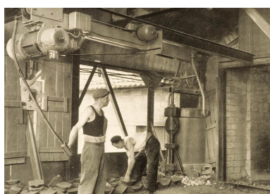
Chargement automatique des cubilots par bennes à fond ouvrant. Phot. Jérôme Mongreville IVR43_20097000081NUC2A
