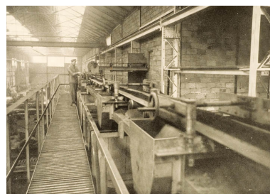
Halle de moulage. Alimentation automatique des machines à mouler. Phot. Jérôme Mongreville IVR43_20097000080NUC2A
