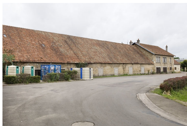
Logements ouvriers et bureau depuis la rue. Phot. Jérôme Mongreville IVR43_20097000823NUC2A
