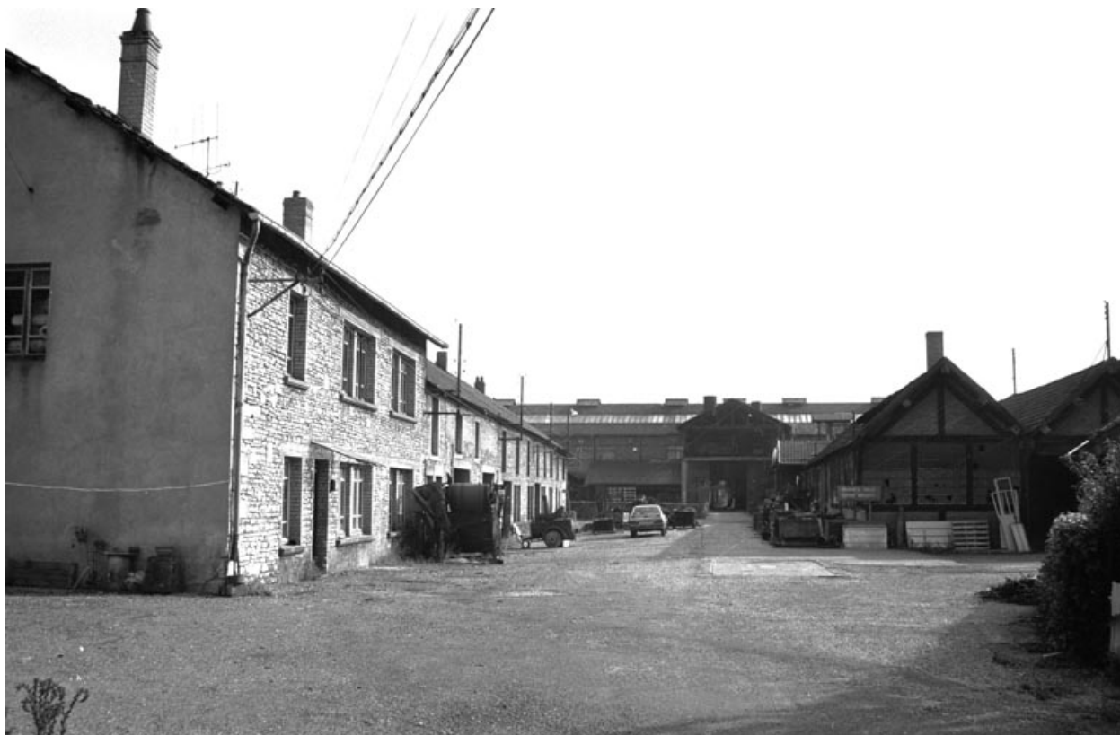
Vue d'ensemble depuis l'entrée en 1987.
