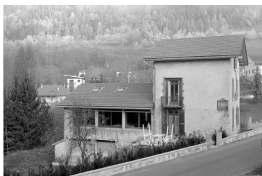
Façade latérale gauche. Phot. Laurent Poupard IVR43_19913901147Z
