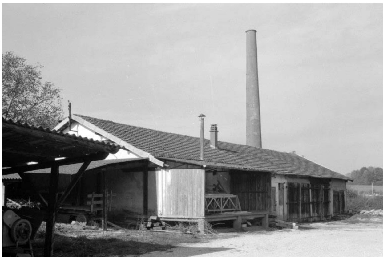
Hangar (C), remise (B) et cheminée d'usine.
