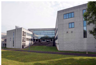
Détail d'un préau de la façade sud. Phot. Mary Ruffinoni IVR43_20137000540NUC4A
