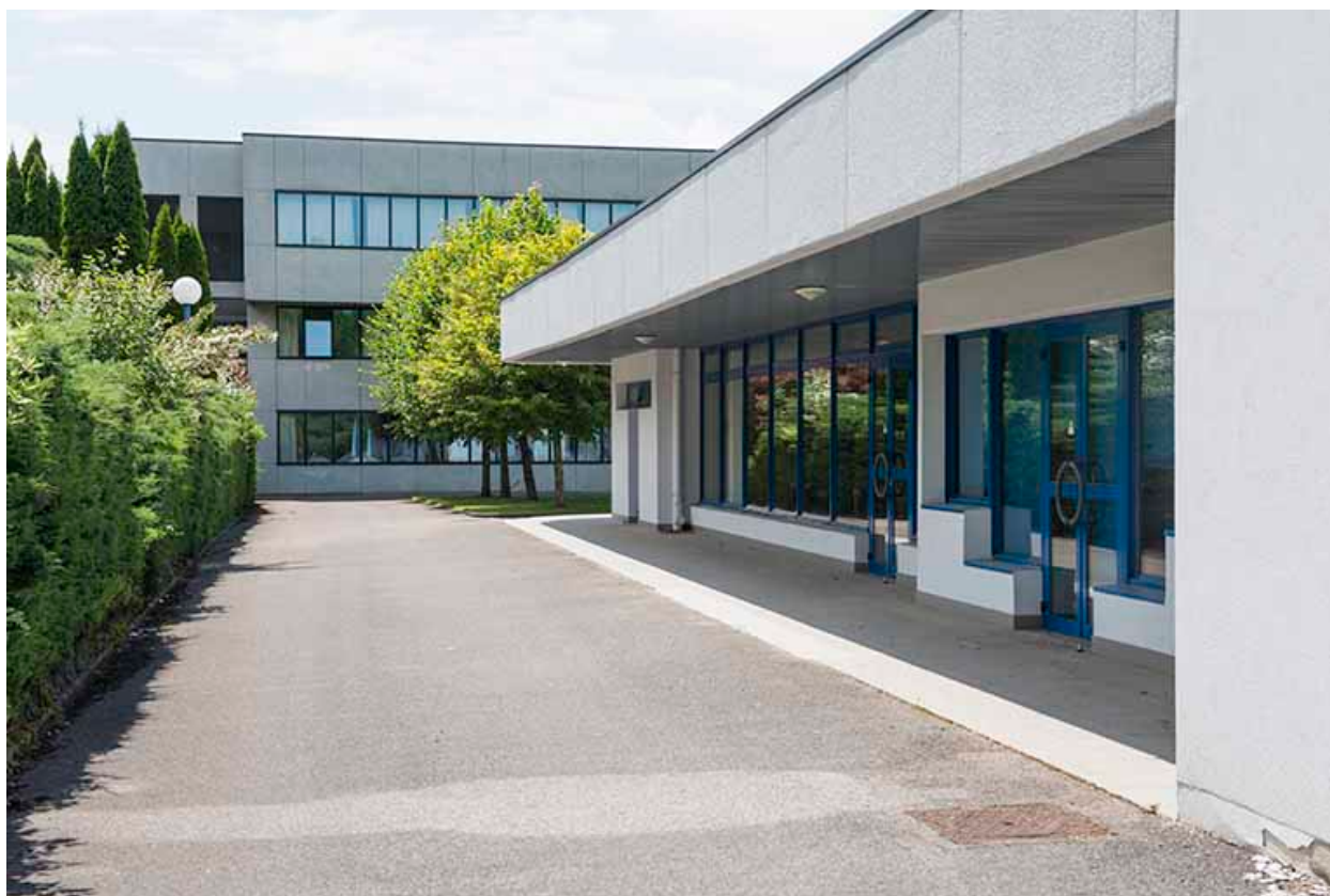
Détail de la façade est de la restauration.
