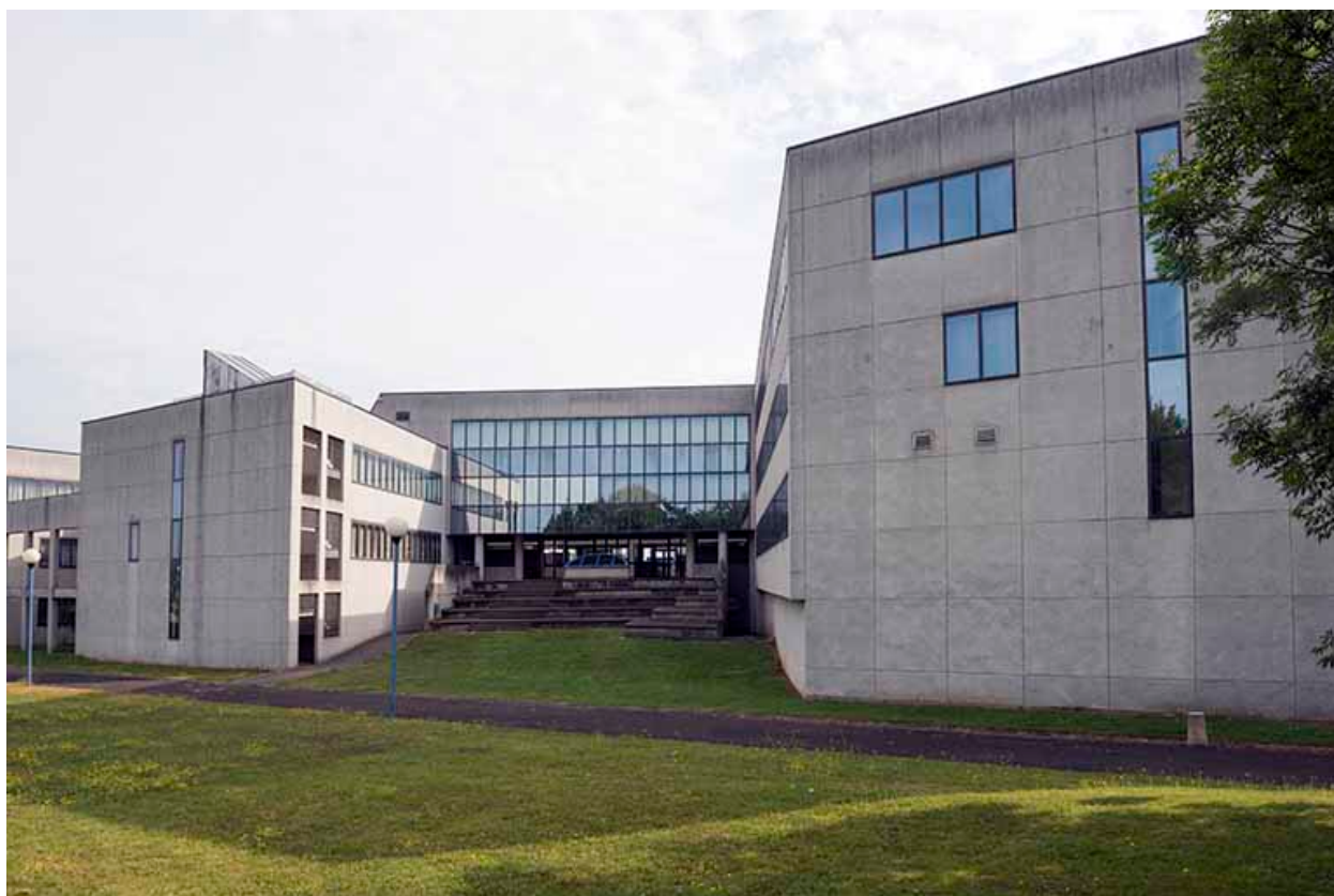
Détail d'un préau de la façade sud.
