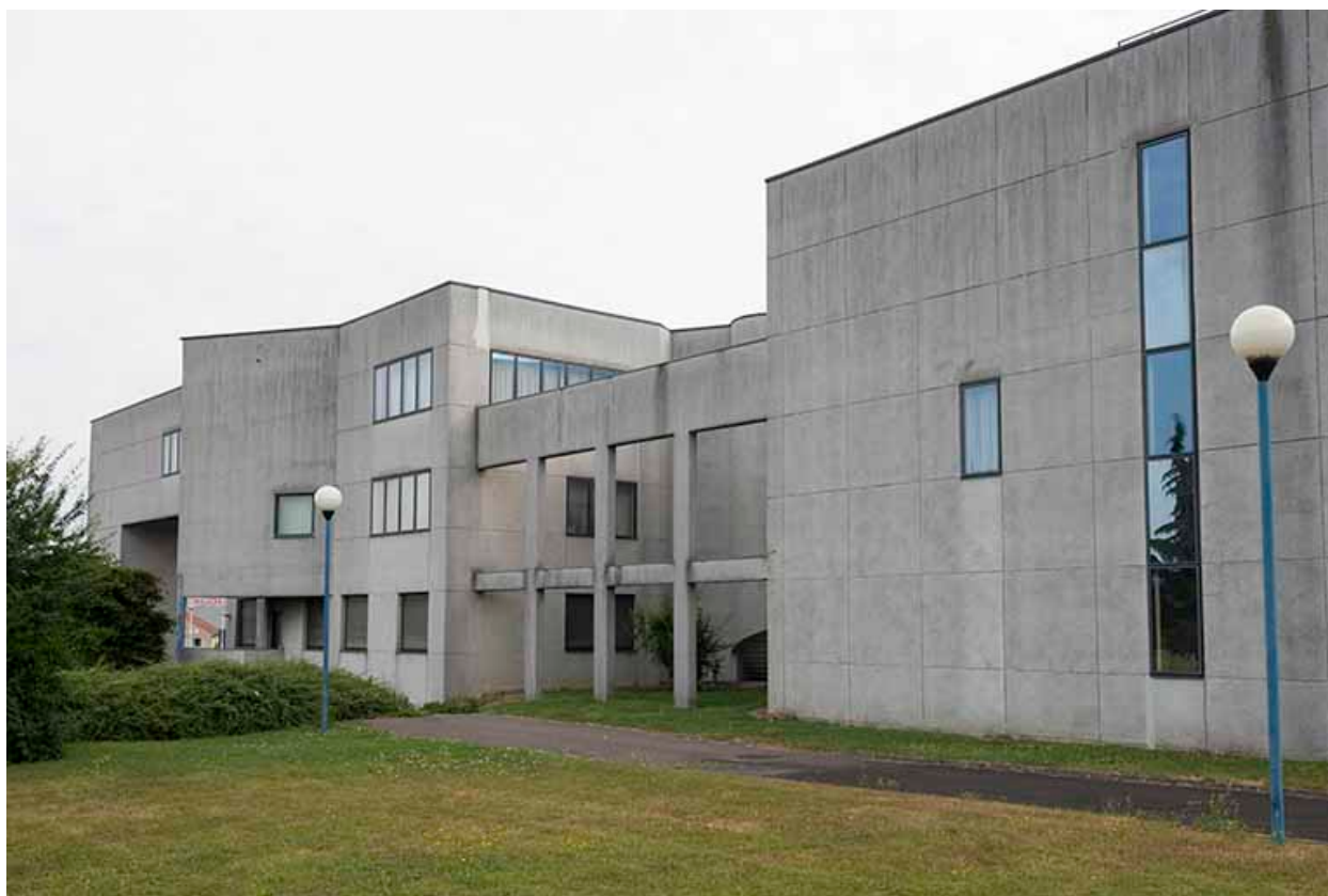
Détail au nord de la façade sud-ouest.
