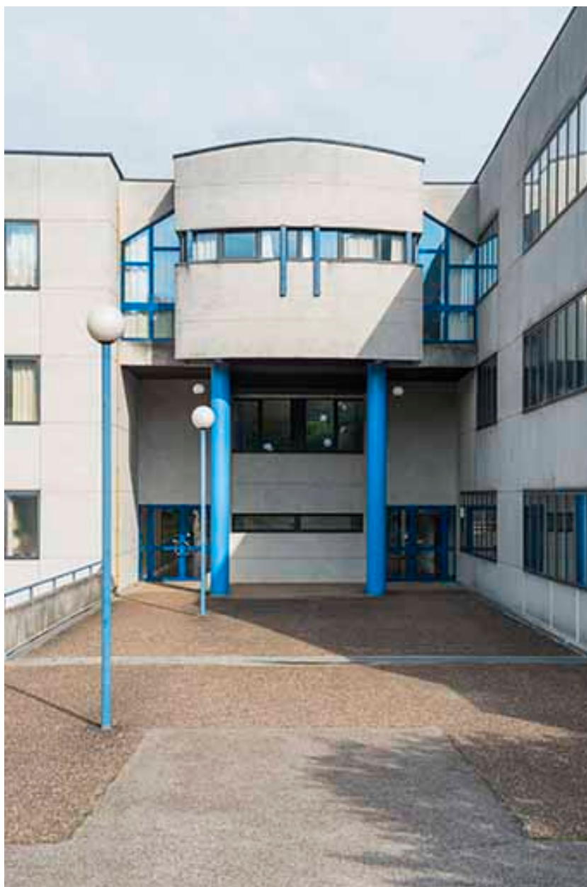
Détail de la façade sud-est, entrée postérieure.
