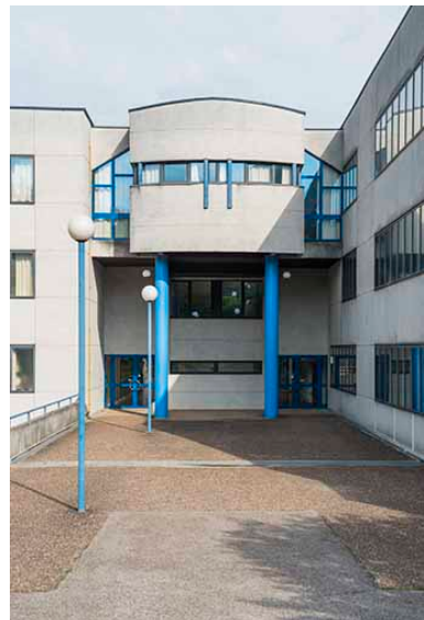
Détail de la façade sud-est, entrée postérieure.
