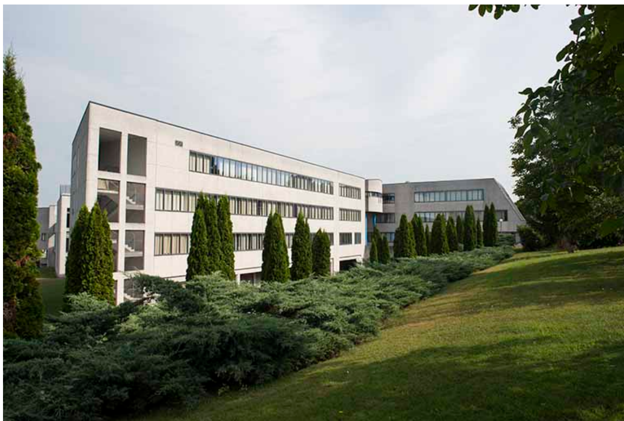
Angle sud, façade est, entrée postérieure.
