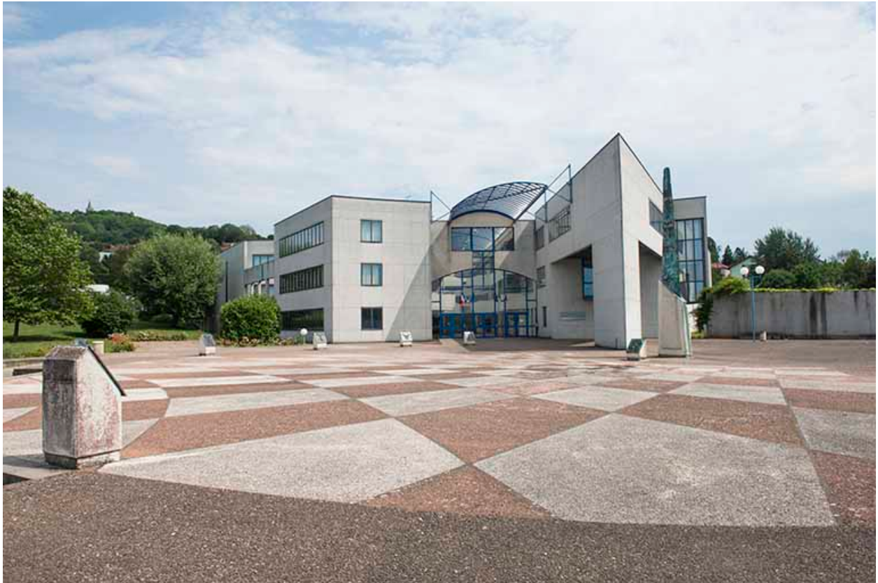
Entrée et façades nord.
