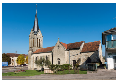
Vue d'ensemble sud-est.
