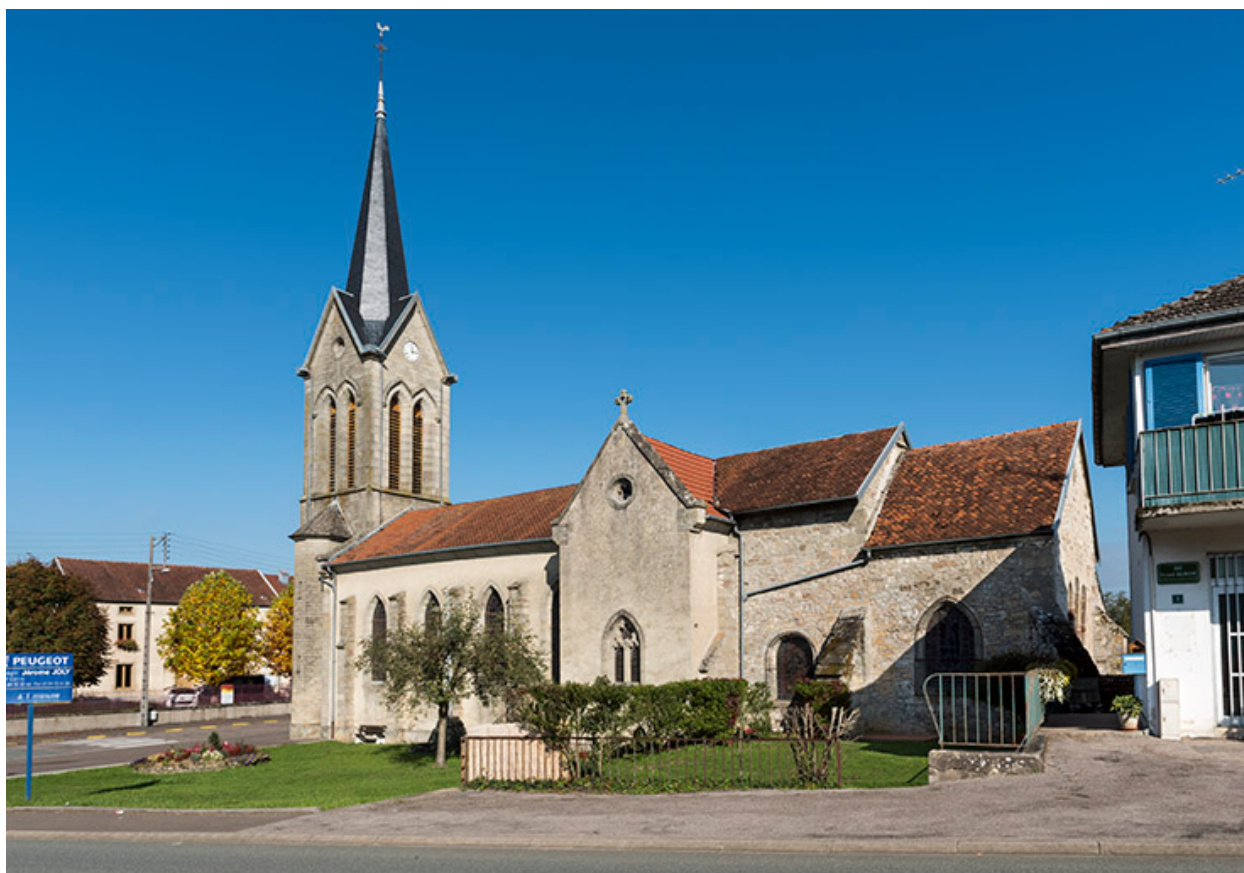
Vue d'ensemble sud-est.
