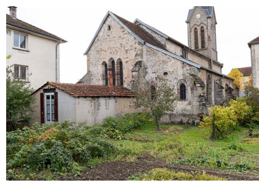
Vue d'ensemble nord-est.
