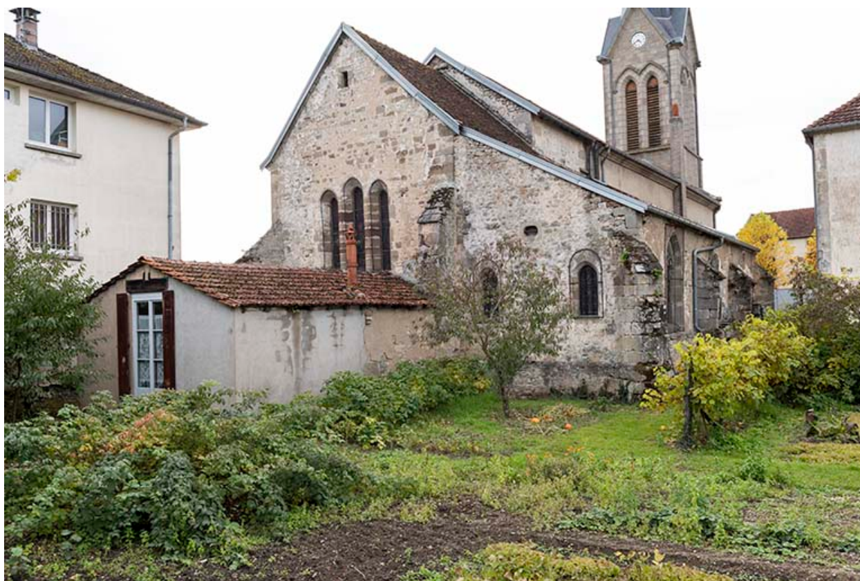
Vue d'ensemble nord-est.
