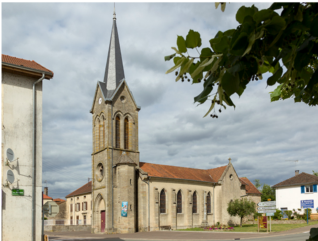
Vue d'ensemble sud-ouest.
