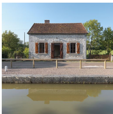
La maison éclusière : vue de face.
