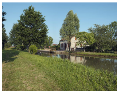
Le site d'écluse, d'amont. Phot. Thierry Kuntz IVR26_20135800241NUC4A
