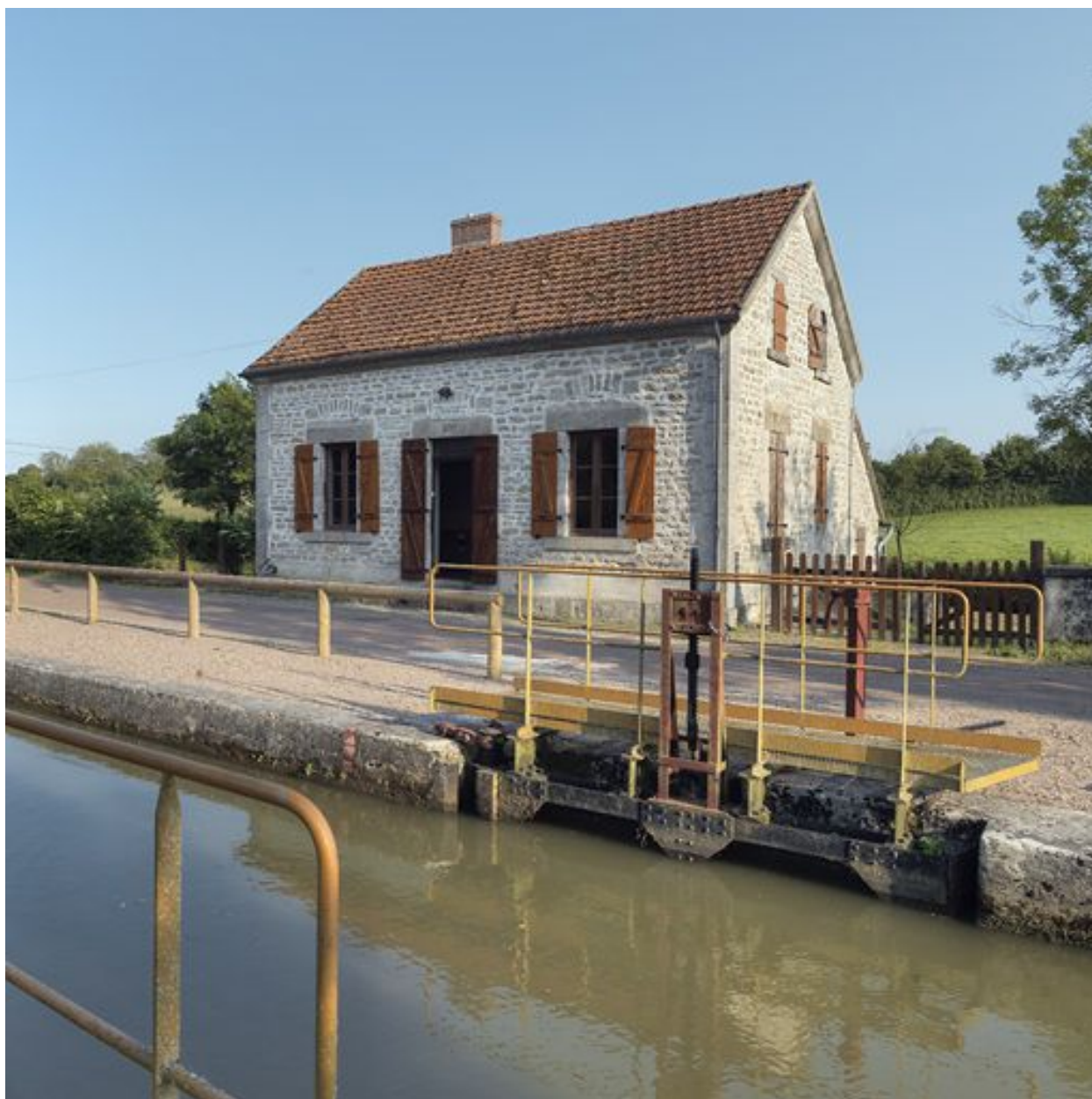
La maison éclusière, vue de 3/4 avant.
