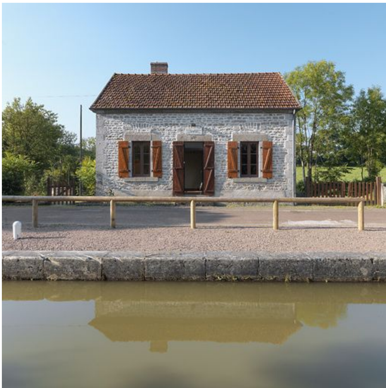
La maison éclusière : vue de face.
