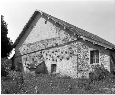
Face latérale gauche. Phot. Yves Sancey IVR43_19802501197X
