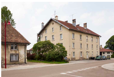
Le logement d'ouvriers. Phot. Yves Sancey IVR43_20132501059NUC2A
