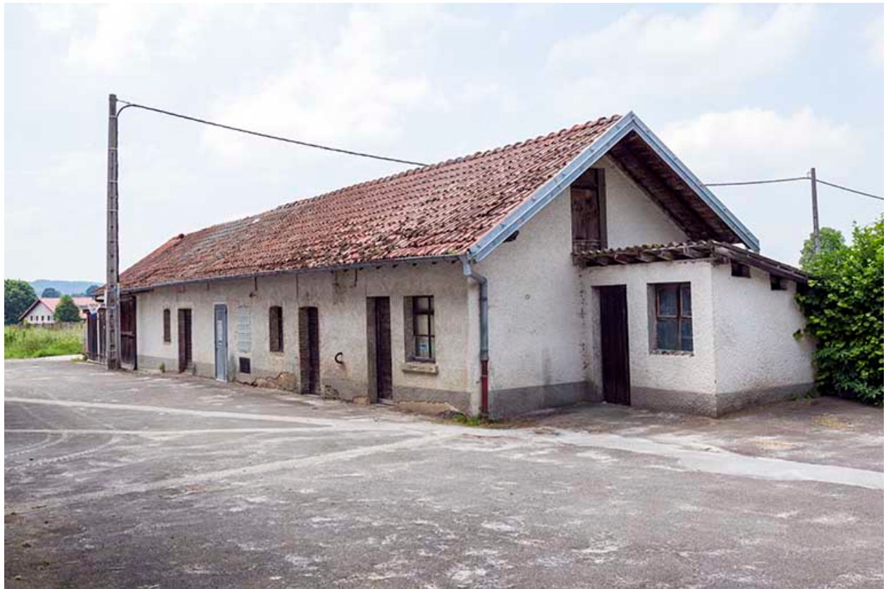
Etable, transformateur et garage.
