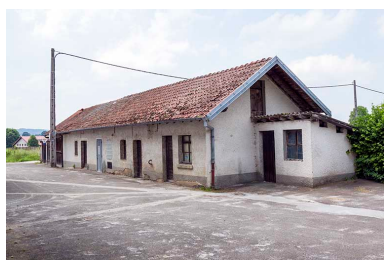
Etable, transformateur et garage. Phot. Yves Sancey IVR43_20132501058NUC2A
