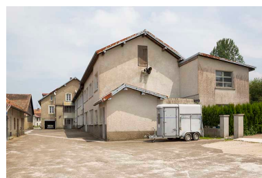
Atelier de fabrication, depuis le sud-ouest. Phot. Yves Sancey IVR43_20132501055NUC2A
