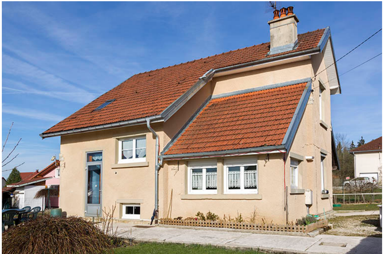
Façades antérieure (pignon) et latérale gauche.
