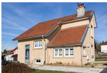
Façades antérieure (pignon) et latérale gauche. Phot. Sonia Dourlot IVR43_20152500727NUC2A
