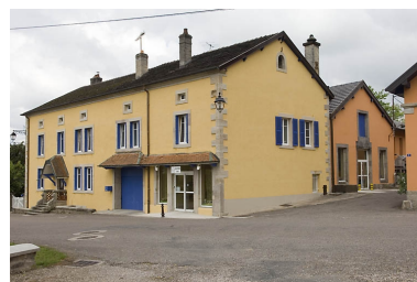
Logement et atelier de distillation. Phot. Jérôme Mongreville IVR43_20077000225NUCA
