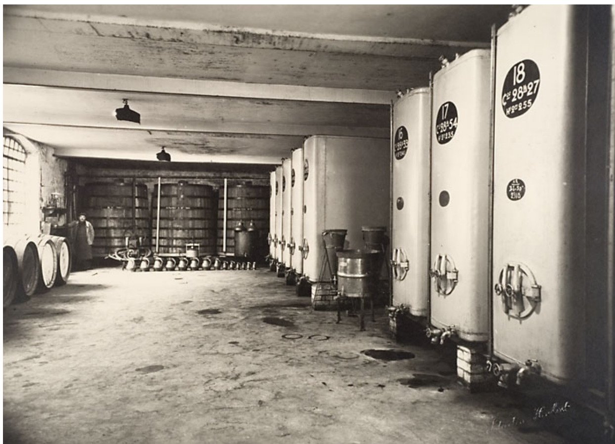
Intérieur de la cuverie.
