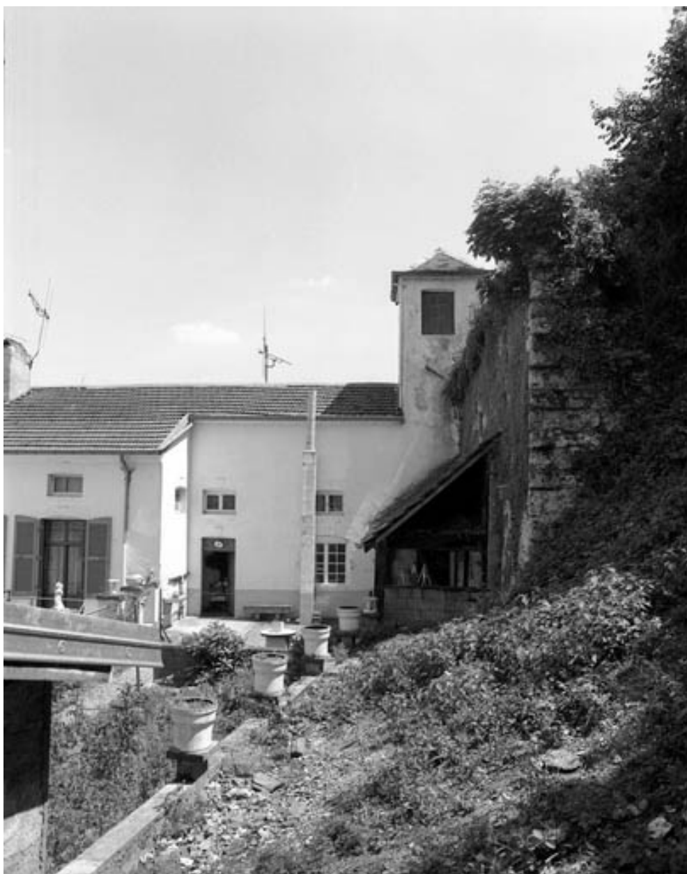
Détail : extrémité de l'aile sur cour.
