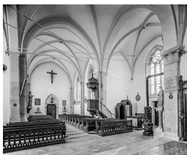
Nef et bras du transept gauche. Phot. Yves Sancey IVR43_19767000678V
