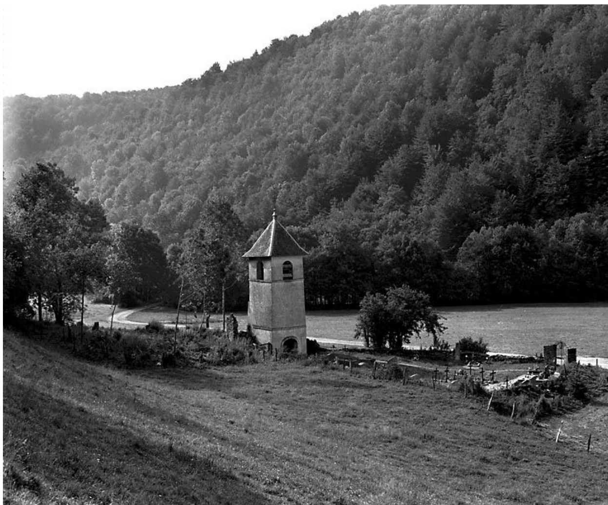
Vue générale depuis le nord-ouest.
