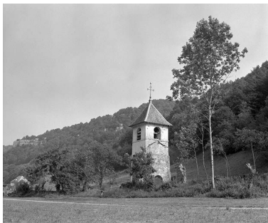
Tour du clocher depuis le sud-est. Phot. Yves Sancey IVR43_19812500229X
