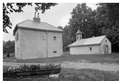
Les Bouchoux : ferme située au lieu-dit Pré Millet. Phot. Jérôme Mongreville IVR43_19943900881X
