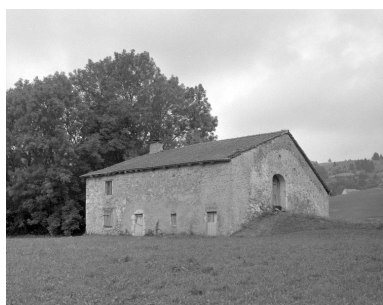
Les Bouchoux : ferme située au lieu-dit L'Enversy. Phot. Jérôme Mongreville IVR43_19943900868X
