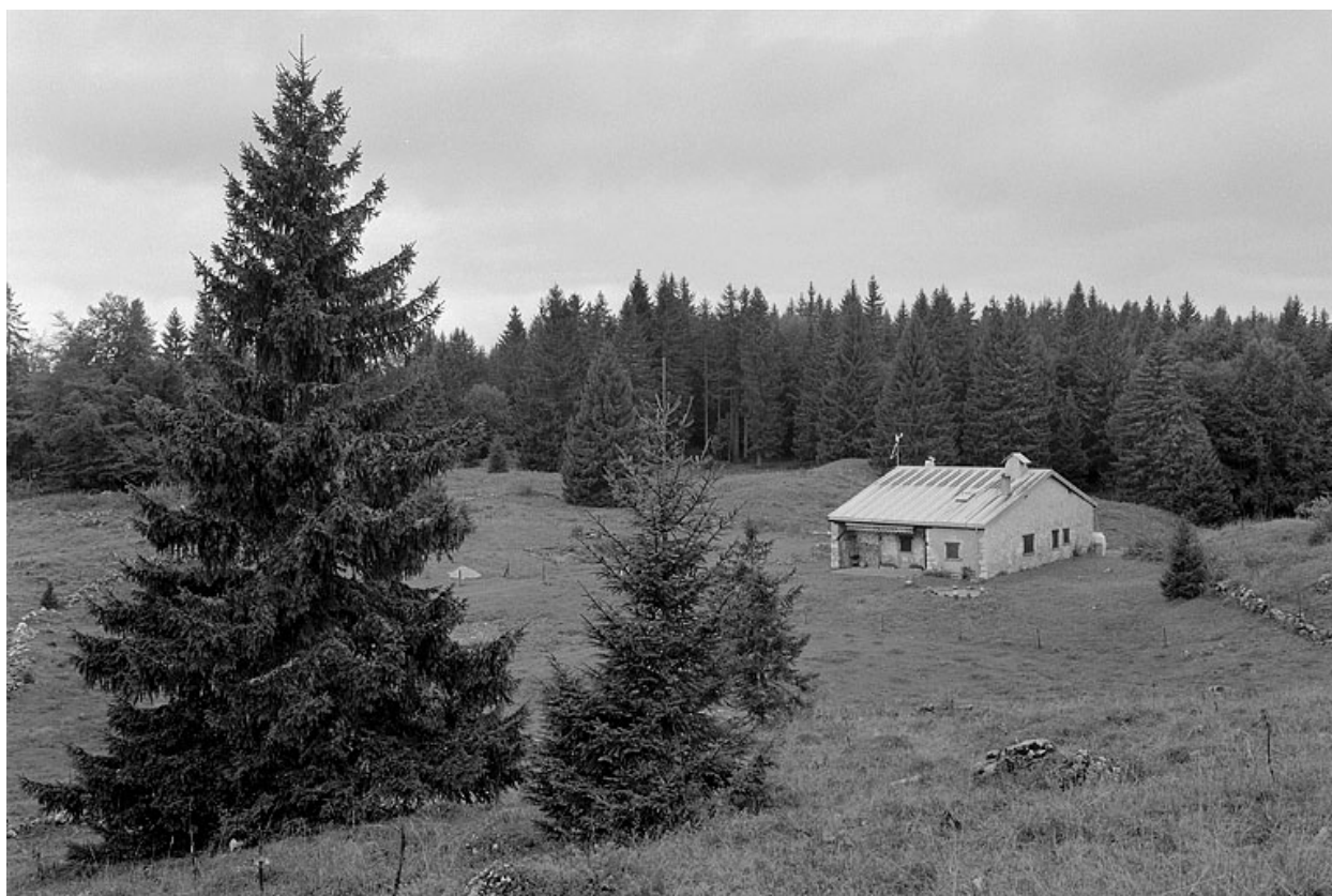
Les Moussières : ferme située au lieu-dit Au Montechoux.
