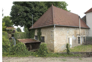
Local de la turbine et atelier. Phot. Jérôme Mongreville IVR43_20087000756NUC2A
