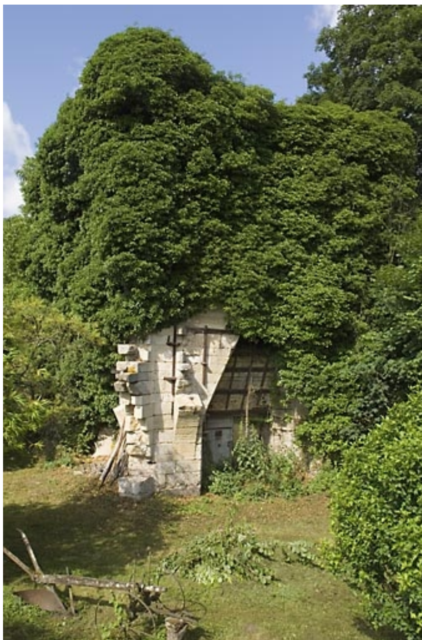
Etat du massif du haut fourneau.
