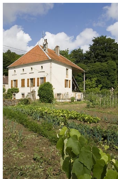
Logement patronal vu depuis le nord-est. Phot. Jérôme Mongreville IVR43_20087000754NUC2A
