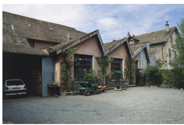
Sheds de l'atelier de fabrication. Phot. Yves Sancey IVR43_19999000400ZA
