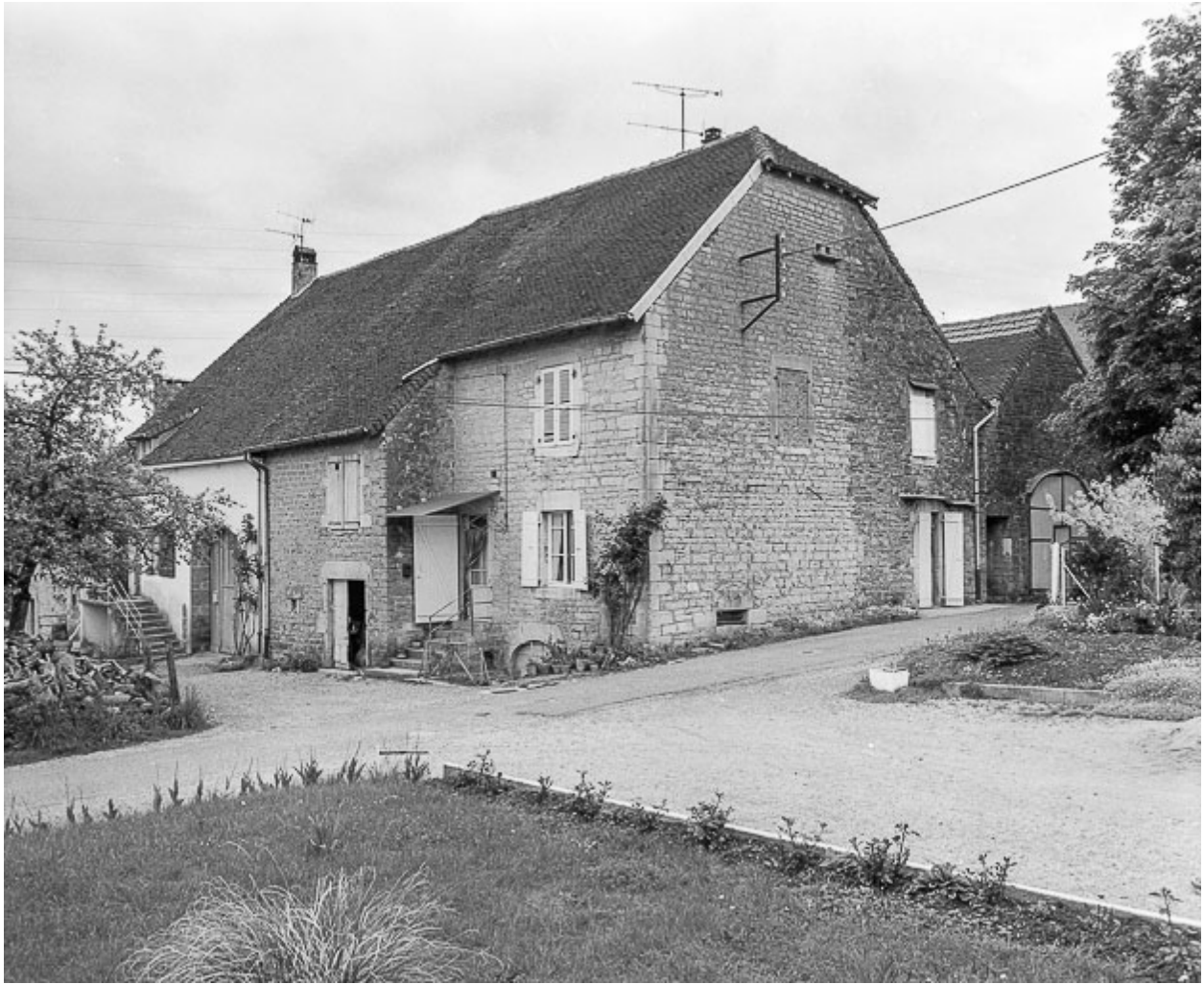
Façades antérieure et latérale droite.
