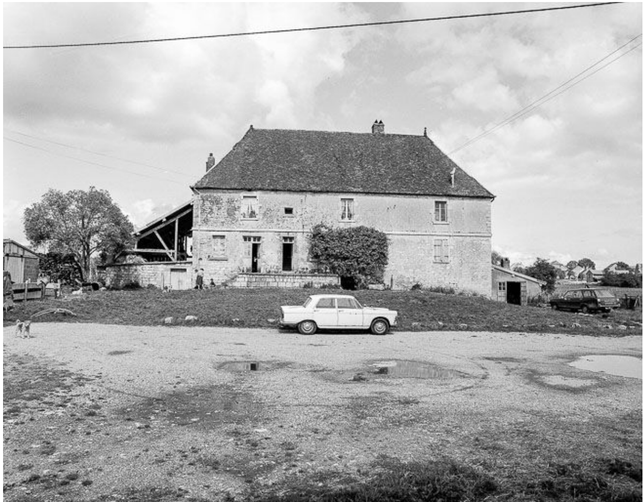
Partie habitation : vue de face.
