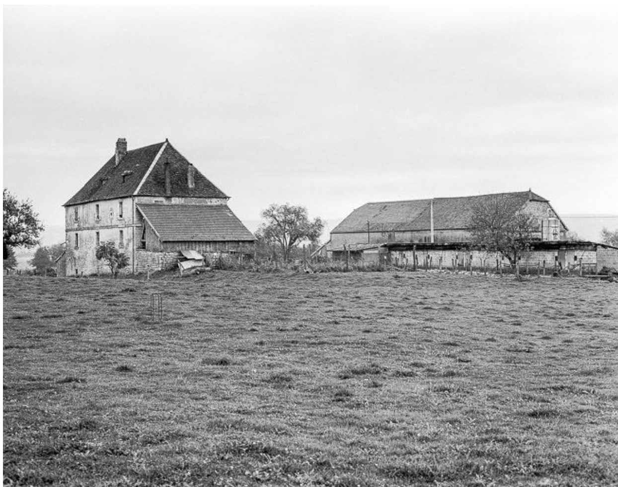
Façades postérieure et latérale droite.
