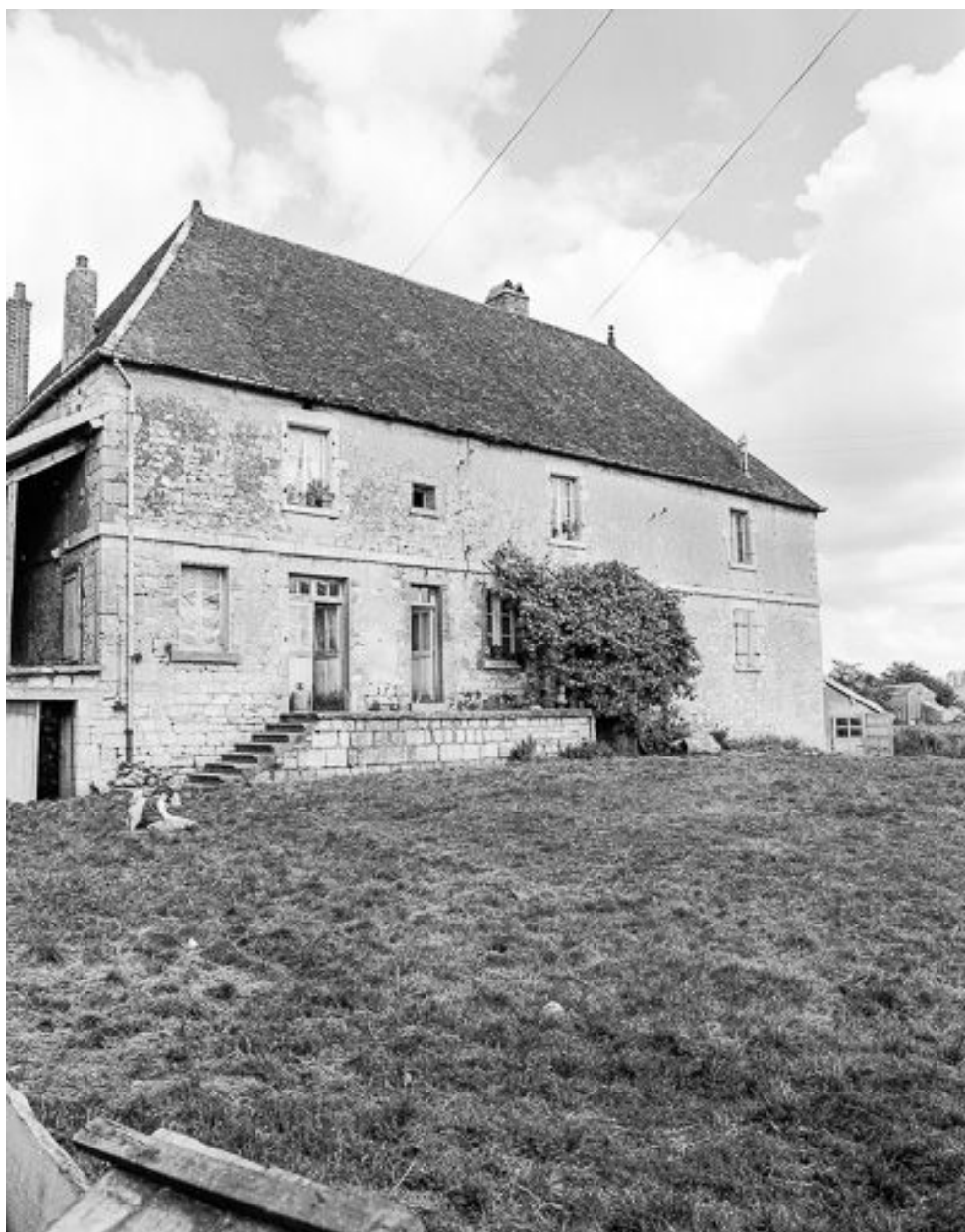
Partie habitation : façade antérieure.
