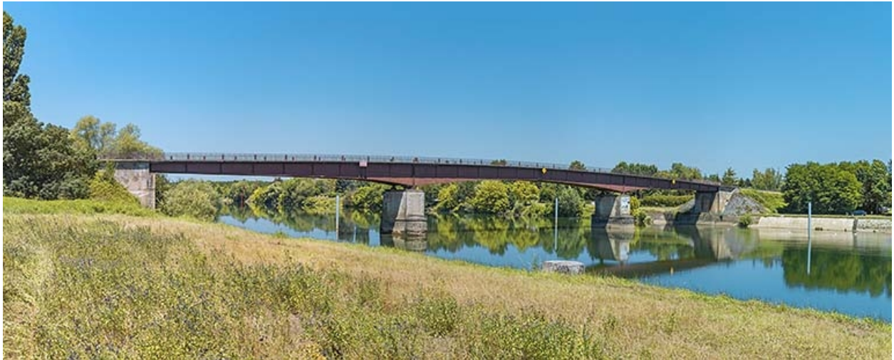
Le pont de Bragny vu d'amont.
