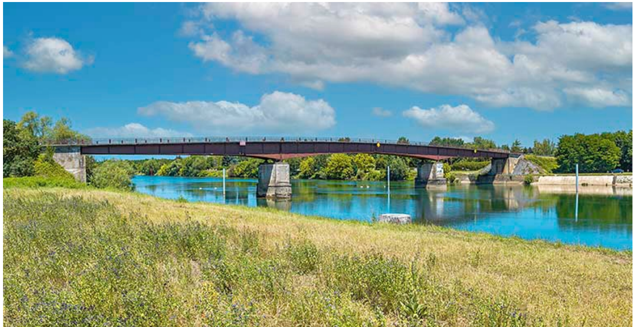
Vue d'ensemble du pont de Bragny.
