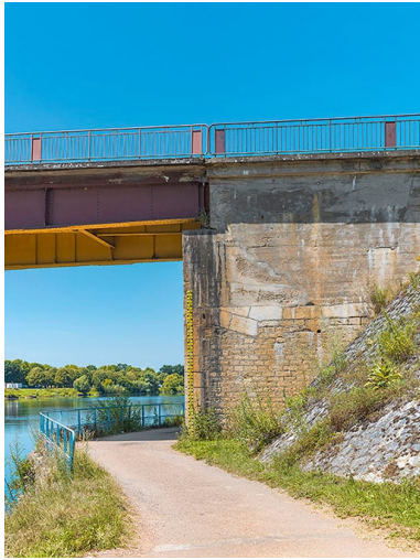
Culée rive droite du pont de Bragny. On lit les différentes phases de reconstruction de l'ouvrage.
