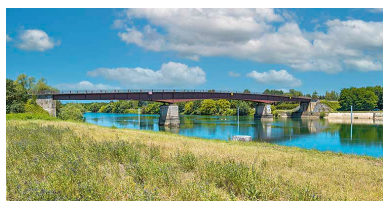
Vue d'ensemble du pont de Bragny.
