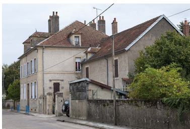
Vue générale de trois quart droit. Phot. Jérôme Mongreville IVR43_20127000645NUC4A
