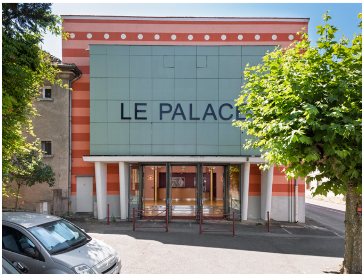
Salle de spectacle : façade antérieure.
