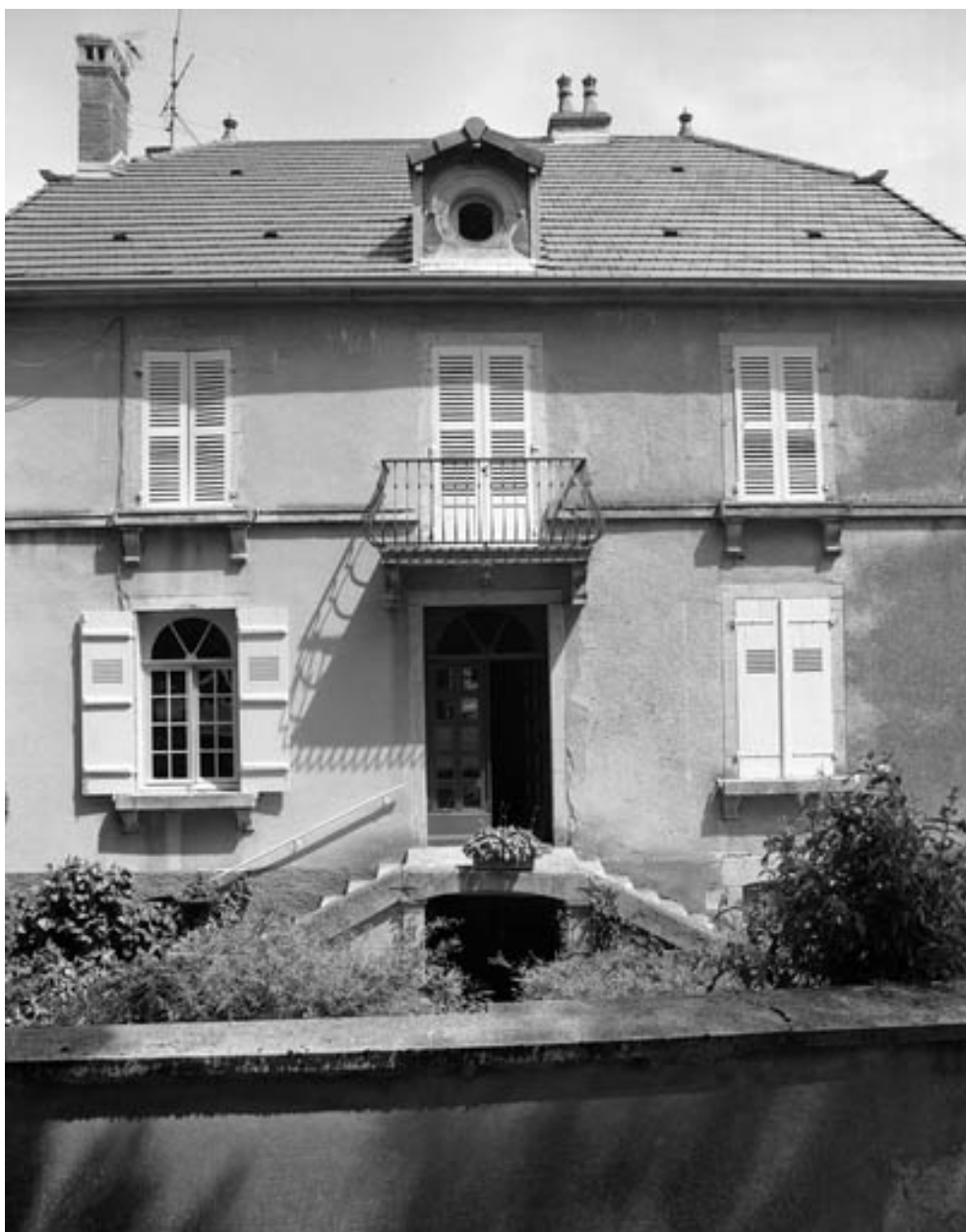
Façade antérieure, de face.
