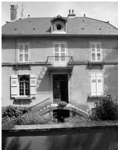
Façade antérieure, de face.
