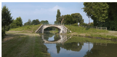
Vue d'amont. Phot. Thierry Kuntz IVR26_20135800296NUC4A
