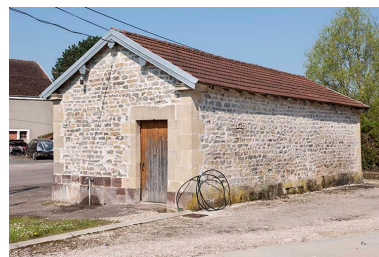
Façade postérieure. Phot. Jérôme Mongreville IVR43_20167000343NUC4A
