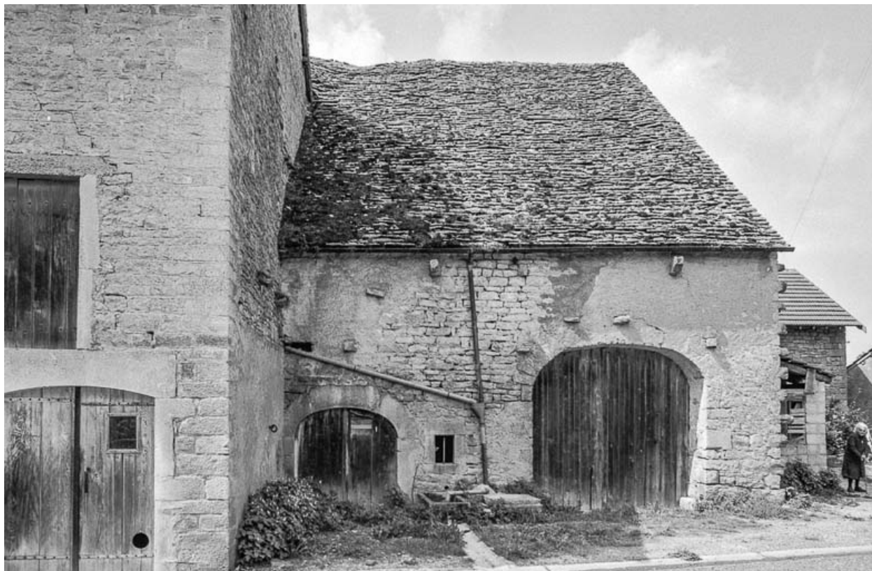
Ferme cadastrée 1951 E1 79 (droite) : façade sur rue.
