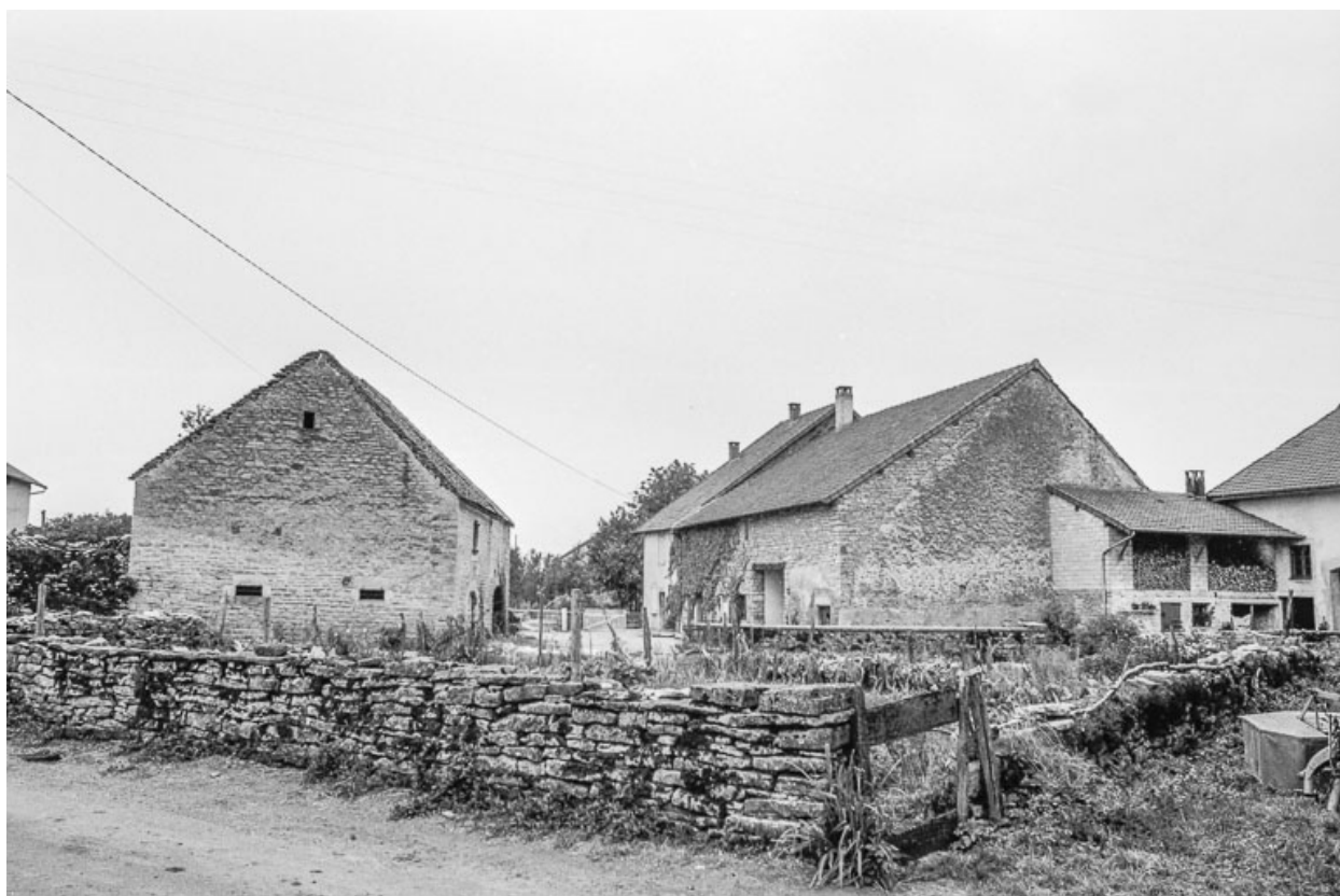
Ferme cadastrée 1951 E1 93 : vue d'ensemble.
