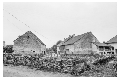
Ferme cadastrée 1951 E1 93 : vue d'ensemble. Phot. Bernard Pontefract IVR43_19763900262Z
