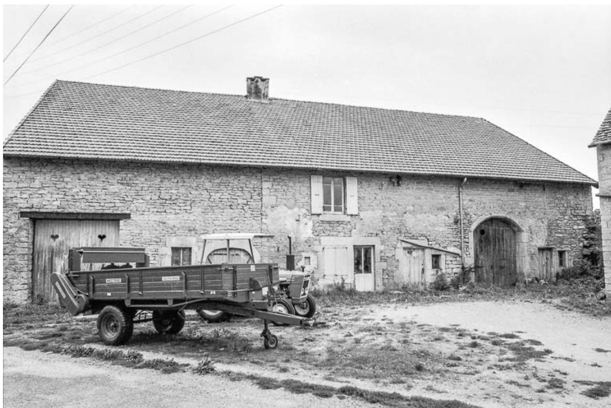
Ferme cadastrée 1951 E1 268 : façade antérieure.
