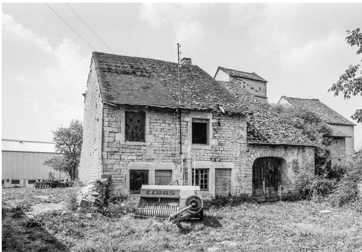
Ferme cadastrée 1951 E1 150 : vue d'ensemble.
