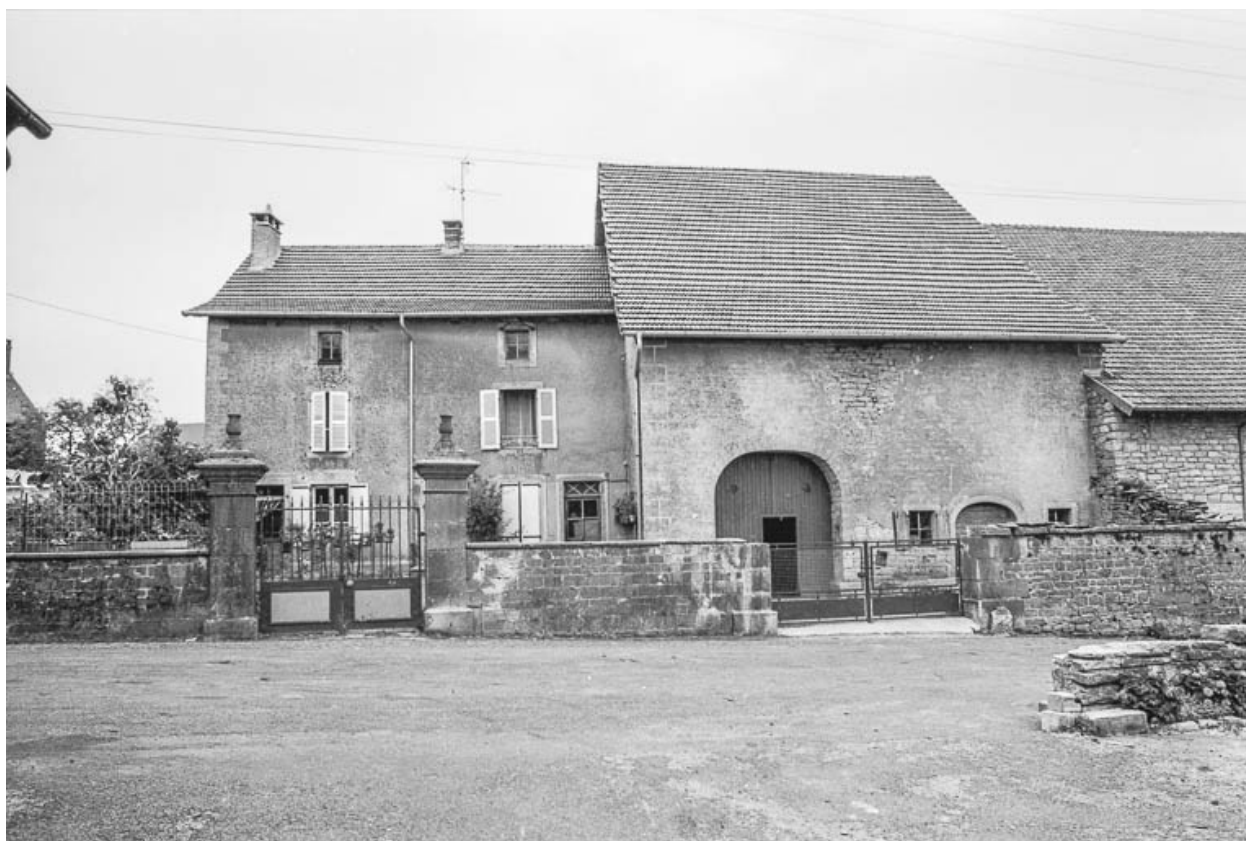
Ferme cadastrée 1951 E1 130 : façade antérieure.
