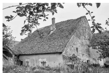
Ferme cadastrée 1951 E1 266 : façade postérieure. Phot. Bernard Pontefract IVR43_19763900265Z
