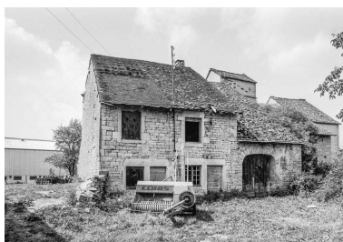
Ferme cadastrée 1951 E1 150 : vue d'ensemble. Phot. Bernard Pontefract IVR43_19763900273Z
