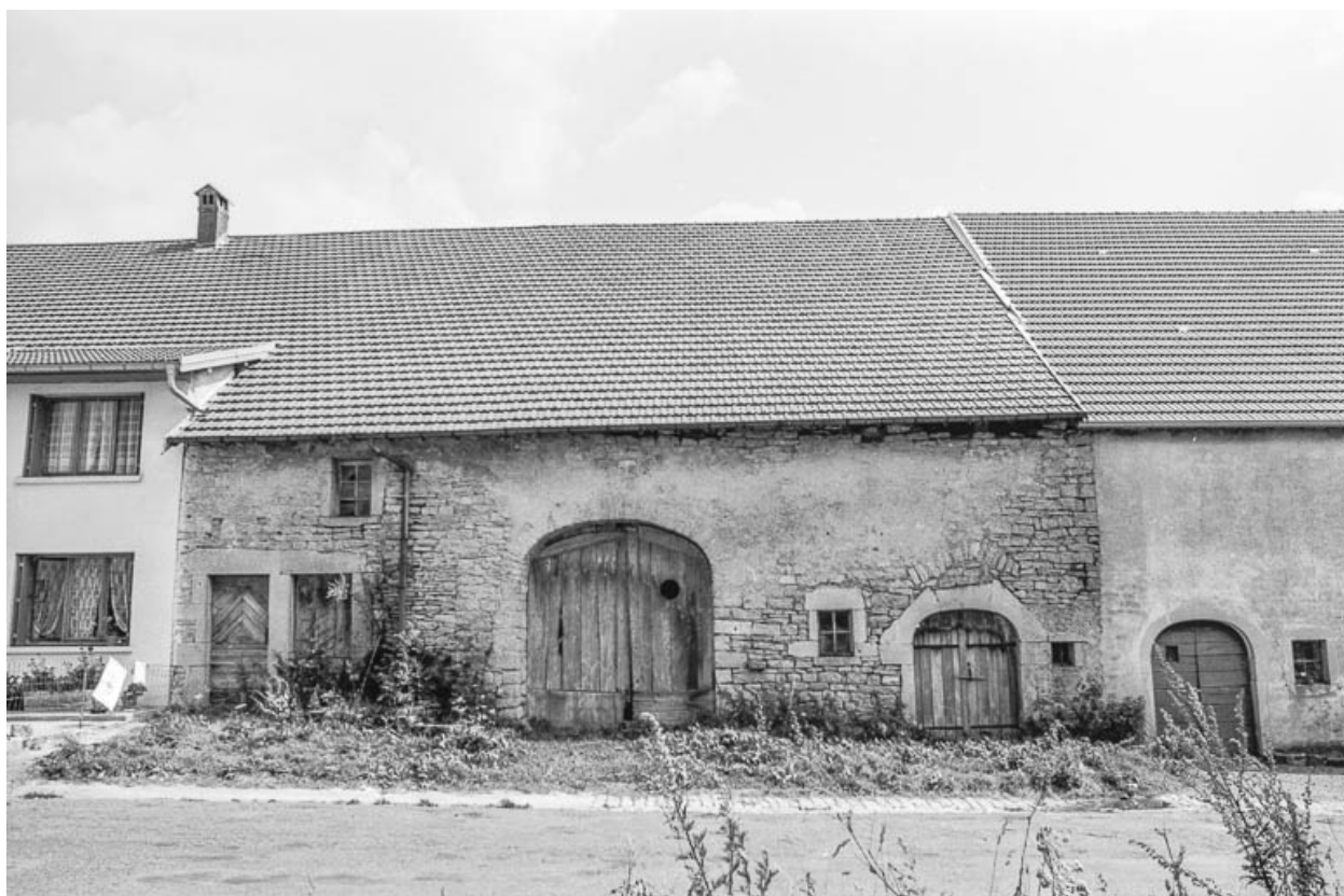
Ferme cadastrée 1951 E1 53 : façade antérieure.
