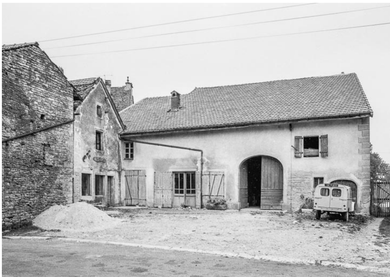
Ferme cadastrée 1951 E1 110 : façade antérieure.
