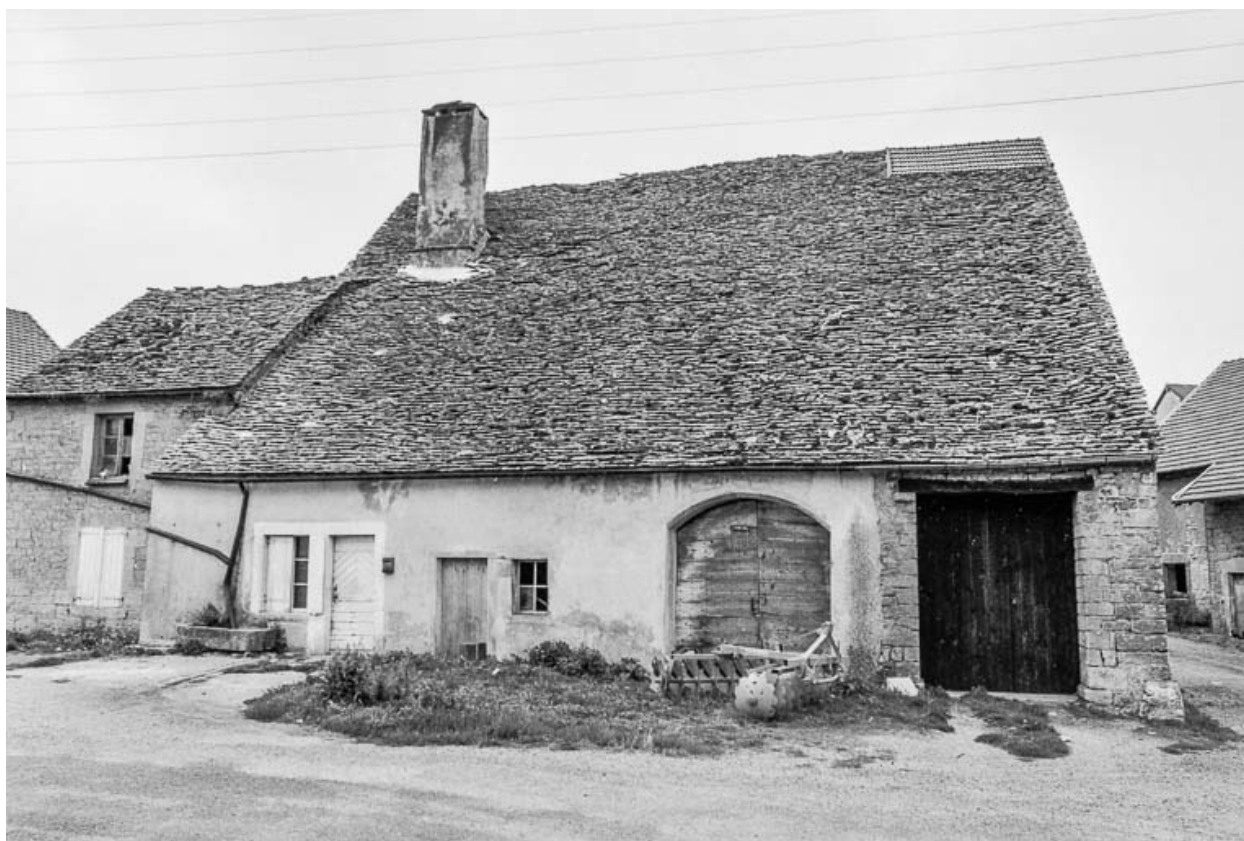
Ferme cadastrée 1951 E1 266 : façade antérieure.
