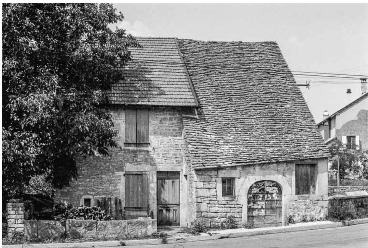
Ferme cadastrée 1951 E1 65 : façade antérieure.
