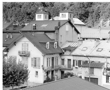
Vue d'ensemble plongeante. Phot. Yves Sancey IVR43_20033900673X
