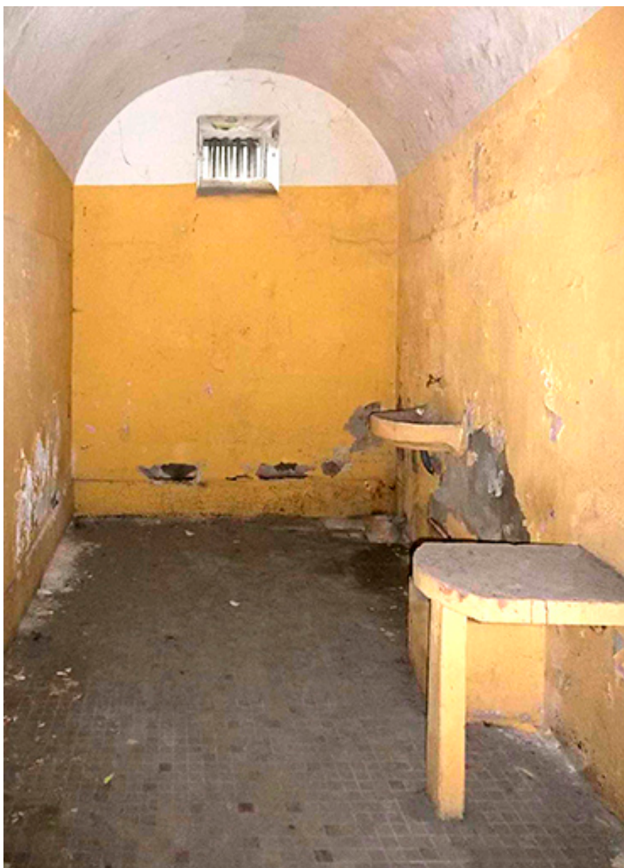
Rez-de-chaussée, cellule de sûreté nord.
