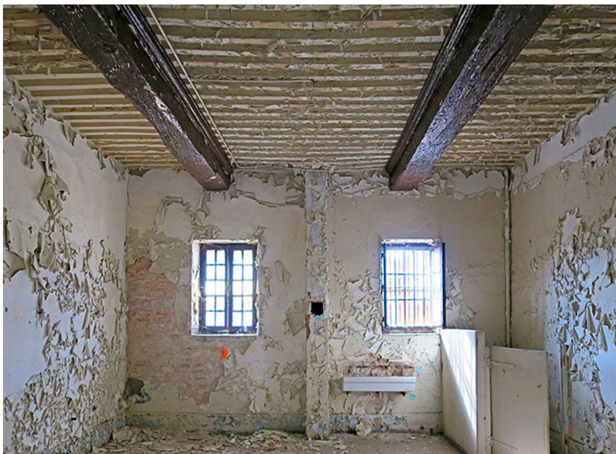
Une des cellules de l'étage.
