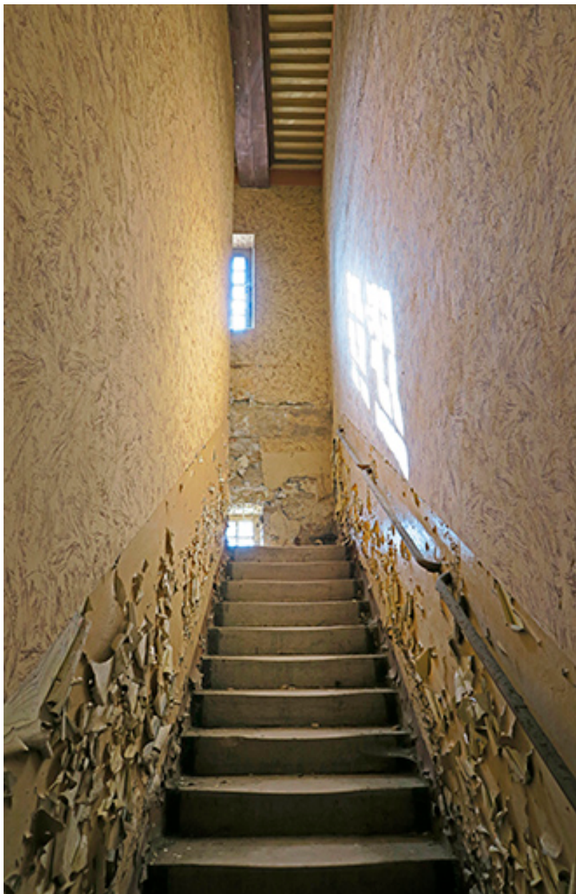
Première volée de l'escalier nord des prisonniers.
