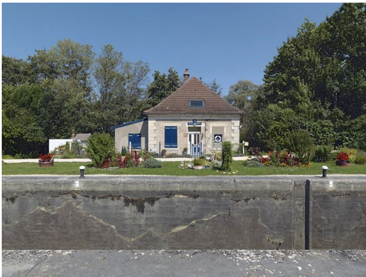
Maison éclusière vue de face.
