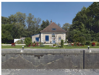
Maison éclusière vue de face. Phot. Thierry Kuntz IVR26_20112103298NUC4A
