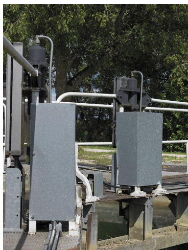
Détail des portes du sas. Phot. Thierry Kuntz IVR26_20112103303NUC4A
