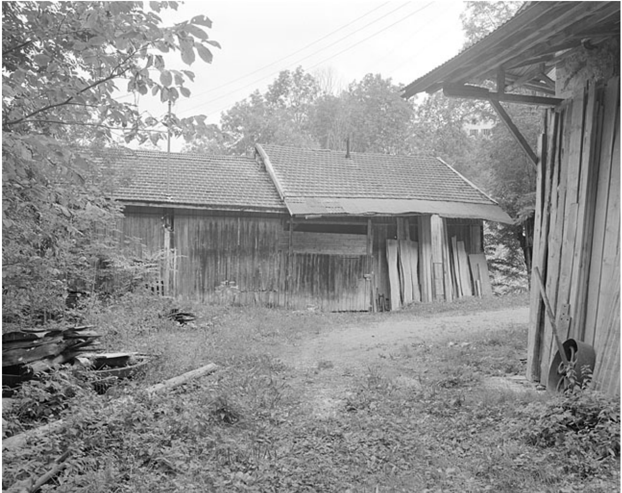
Façade antérieure de la scierie.
