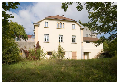
Façade latérale droite. Phot. Jérôme Mongreville IVR43_20082501028NUC2A
