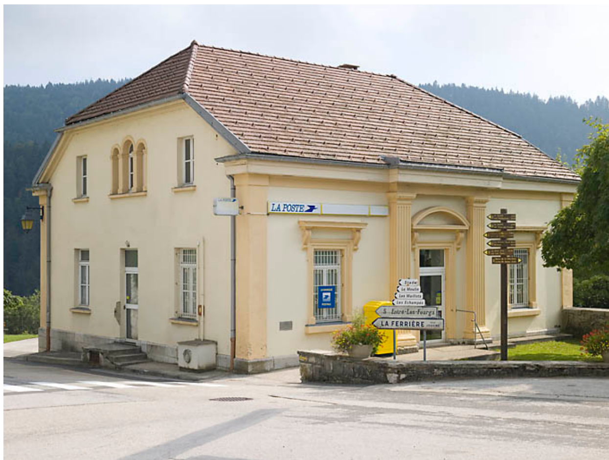
Façade antérieure et façade latérale gauche.
