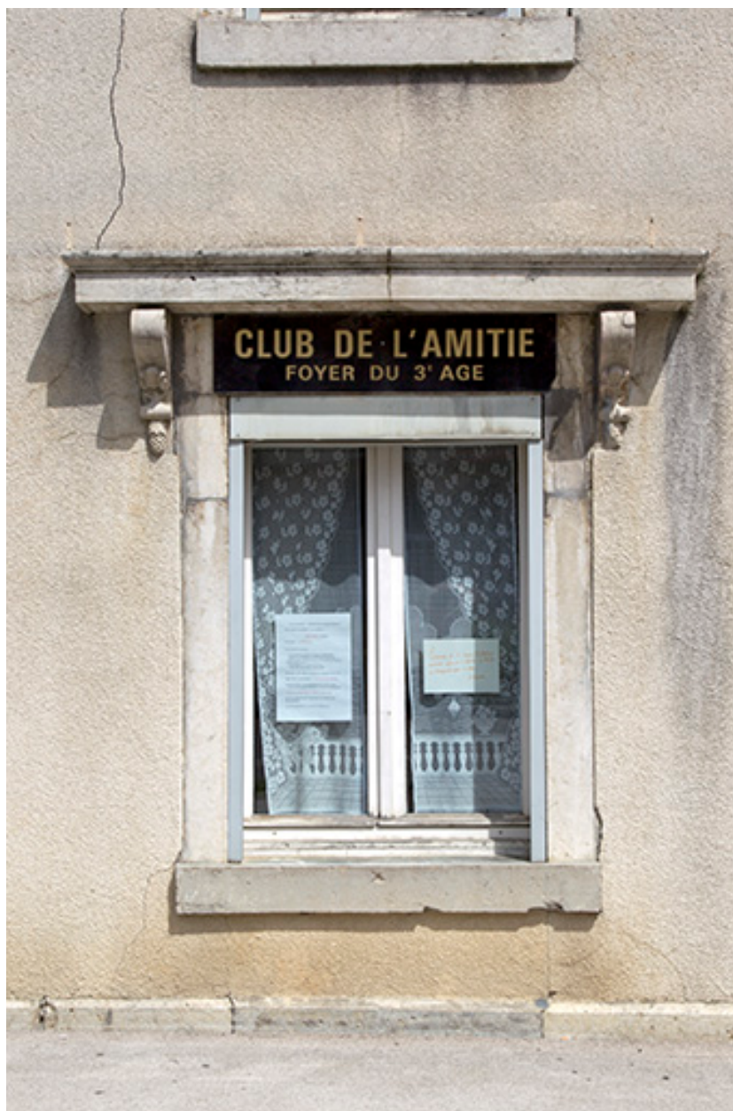
Logement patronal : fenêtre sur la façade antérieure.
