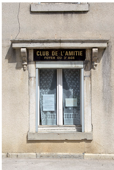
Logement patronal : fenêtre sur la façade antérieure.
