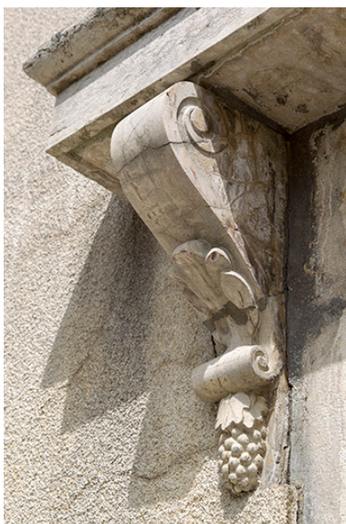
Logement patronal : console soutenant le dessus-de- fenêtre (façade antérieure).
