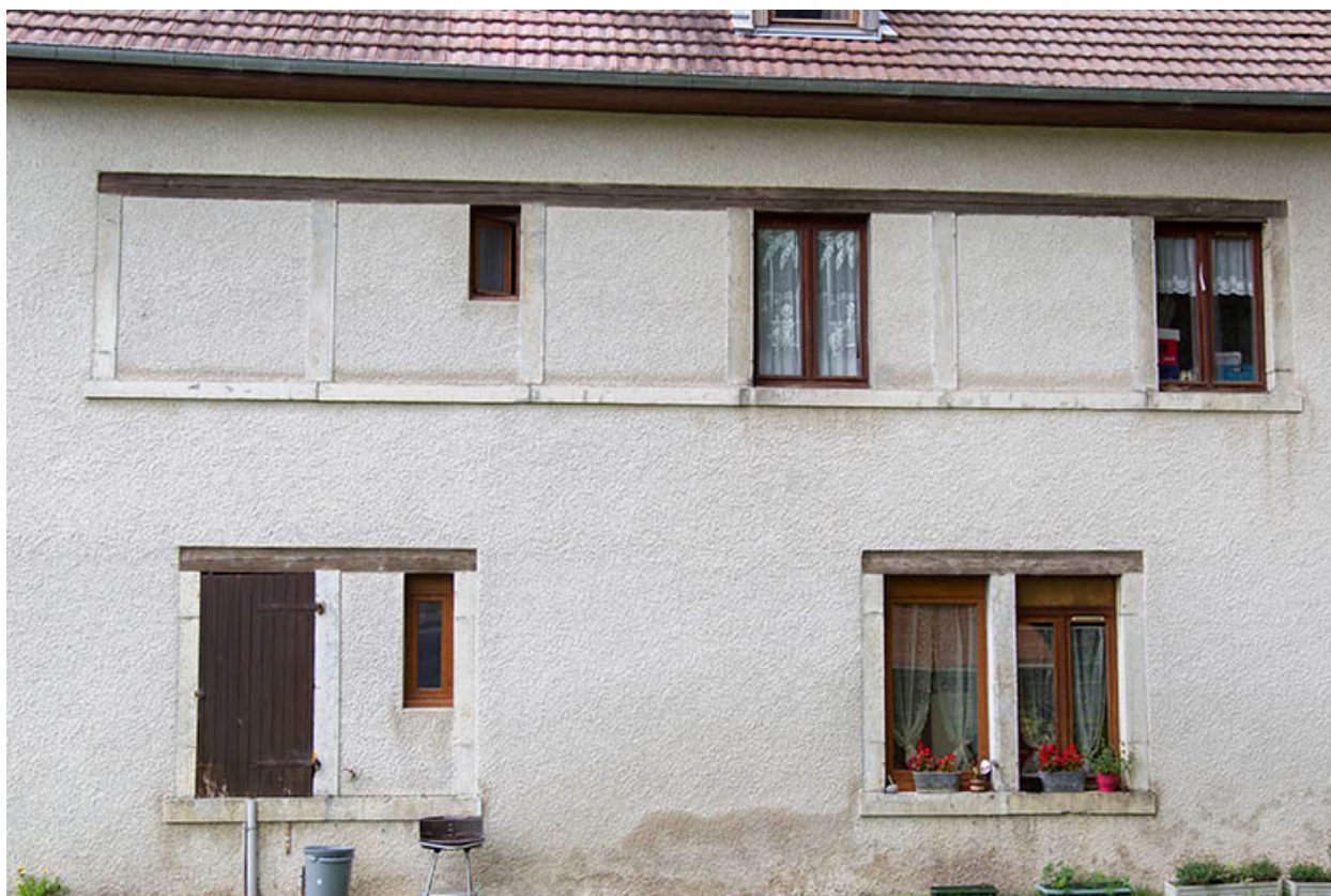
Usine : fenêtres horlogères au rez-de-chaussée et fenêtres multiples à l'étage (façade postérieure).
