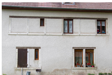
Usine : fenêtres horlogères au rez- de-chaussée et fenêtres multiples à l'étage (façade postérieure). Phot. Sonia Dourlot IVR43_20142501834NUC2A
