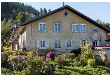
Façade latérale gauche. Phot. Sonia Dourlot IVR43_20162501704NUC4A
