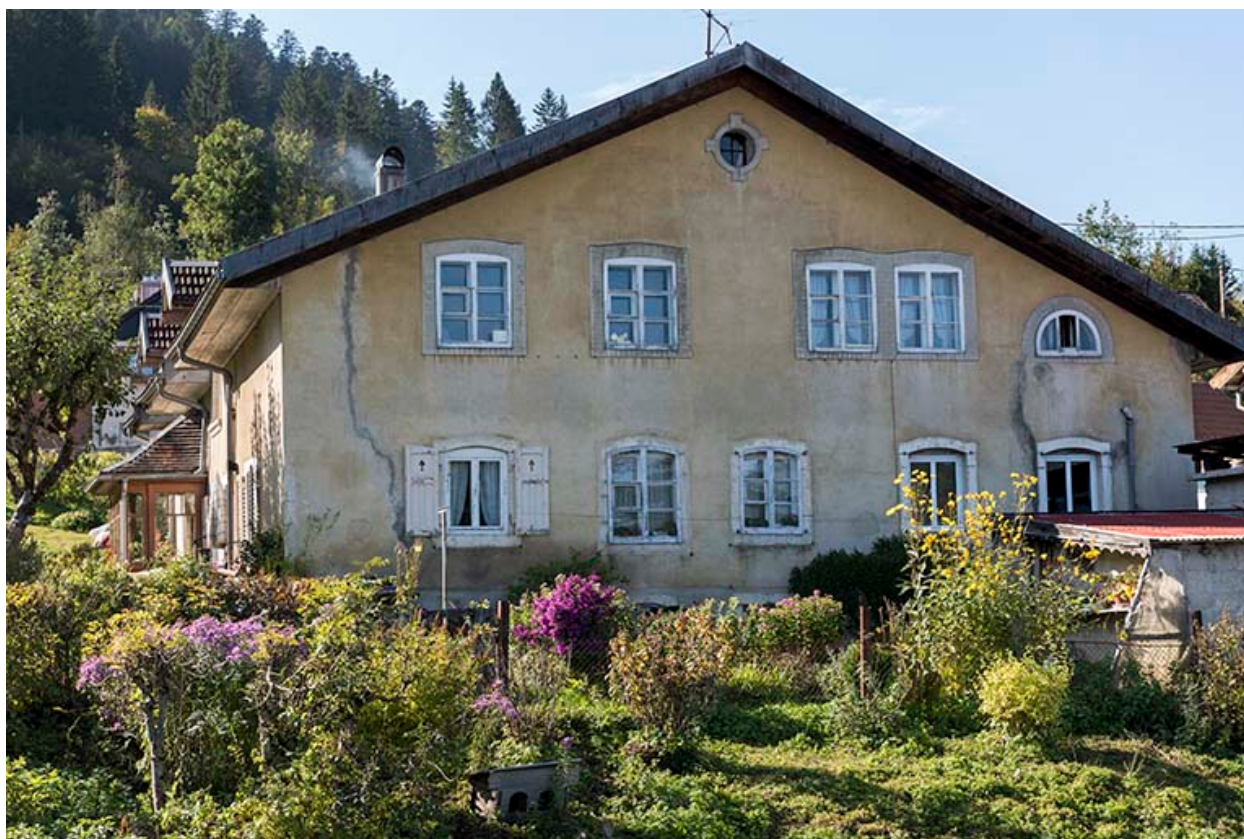
Façade latérale gauche.
