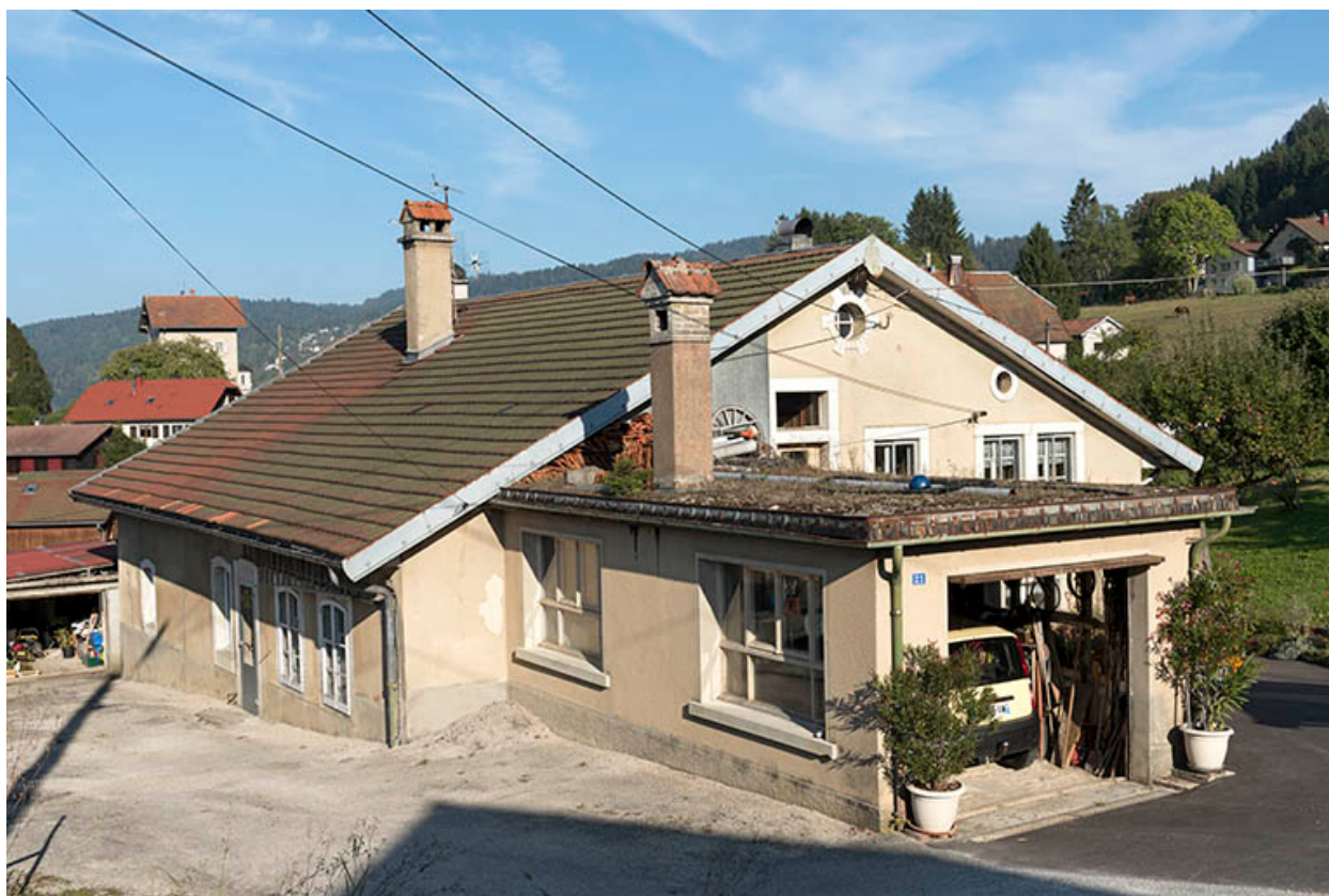
Façades antérieure et latérale droite.
