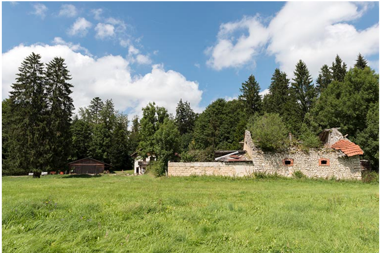
Vestiges de la porcherie, depuis le sud.
