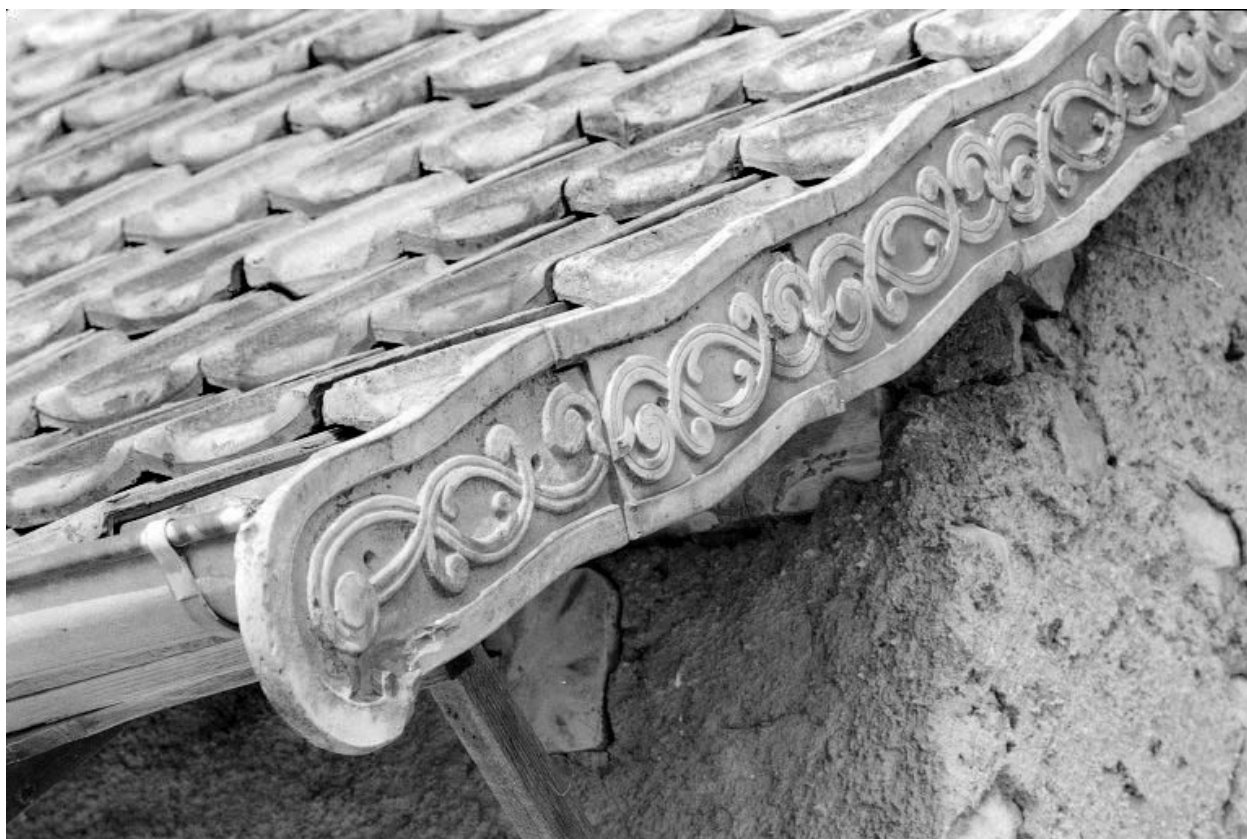
Pignon droit de la remise : détail.
