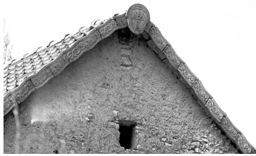
Vue du pignon droit de la remise. Phot. Bernard Lardière IVR43_19829000250Z
