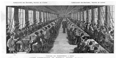
L'atelier des échappements à ancre [de la Grande Fabrique], 1885.
