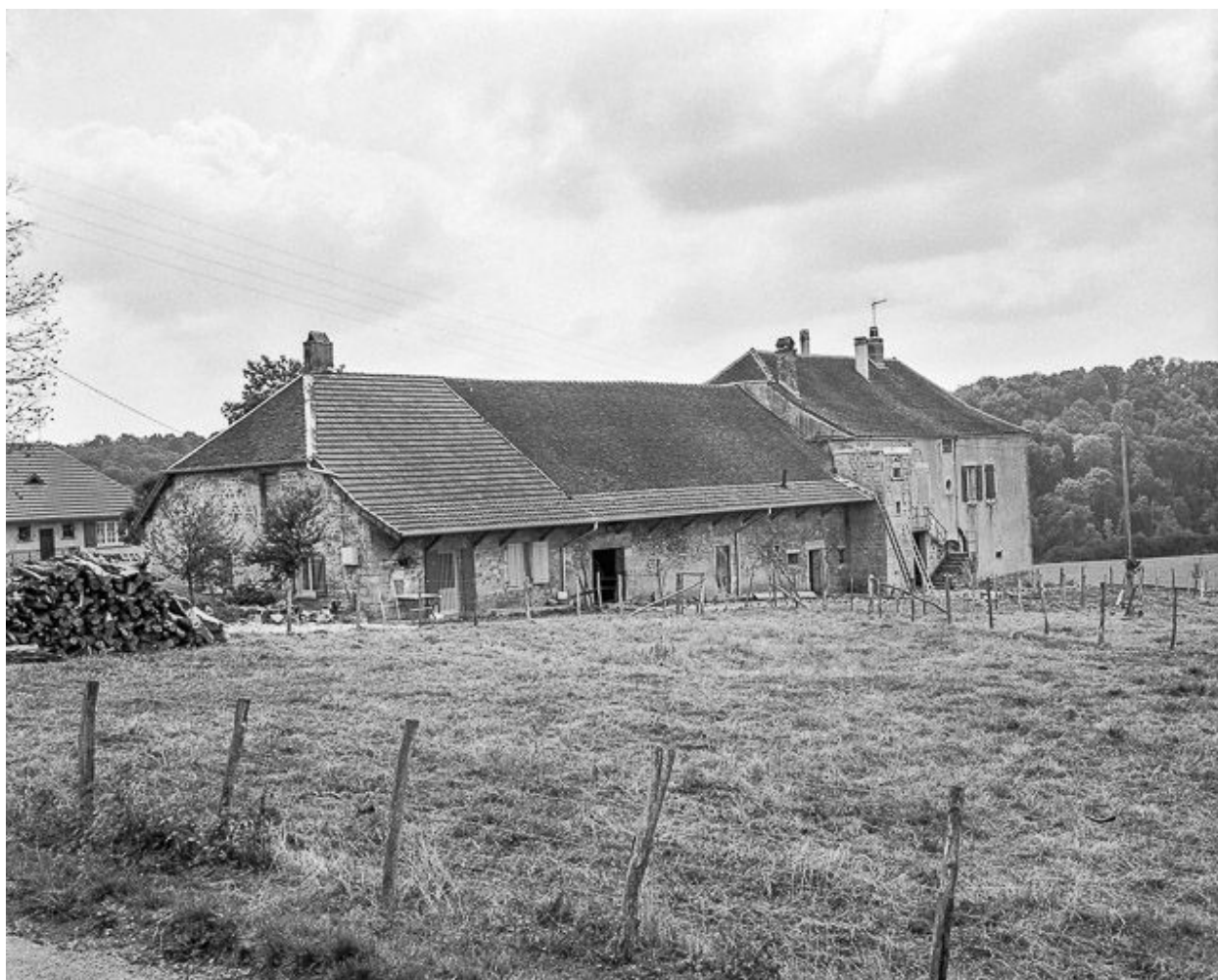
Vue générale de la face postérieure.
