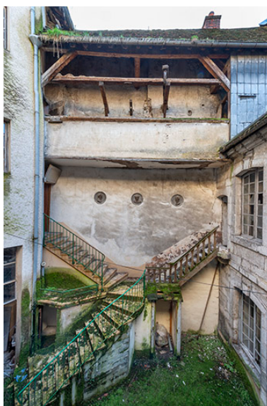
Mur sud de la cour. Phot. Jérôme Mongreville IVR43_20243900030NUC4A
