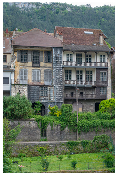
Vue d'ensemble depuis l'ouest (façade de gauche). Phot. Jérôme Mongreville IVR43_20233900455NUC4A
