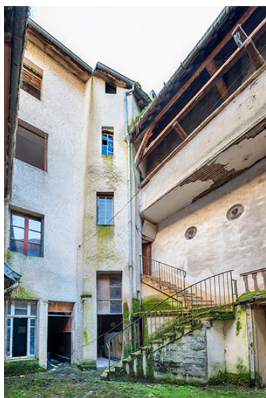
Vue depuis le nord-ouest de la cour : tour d'escalier et mur sud. Phot. Jérôme Mongreville IVR43_20243900027NUC4A
