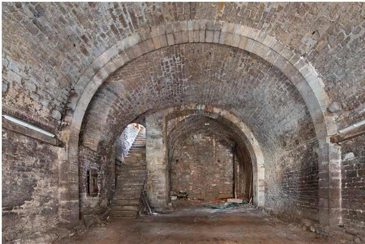
Cave : vue depuis l'ouest.
