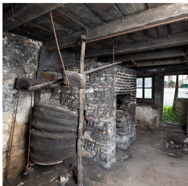
Auberge de la Pomme d'Or et atelier Vannier-Ruhier puis Faivre, 1 Grande Rue : intérieur de la forge.
