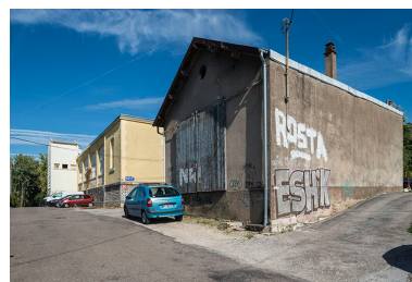
Façade ouest des ateliers. Phot. Jérôme Mongreville IVR43_20182500513NUC4A
