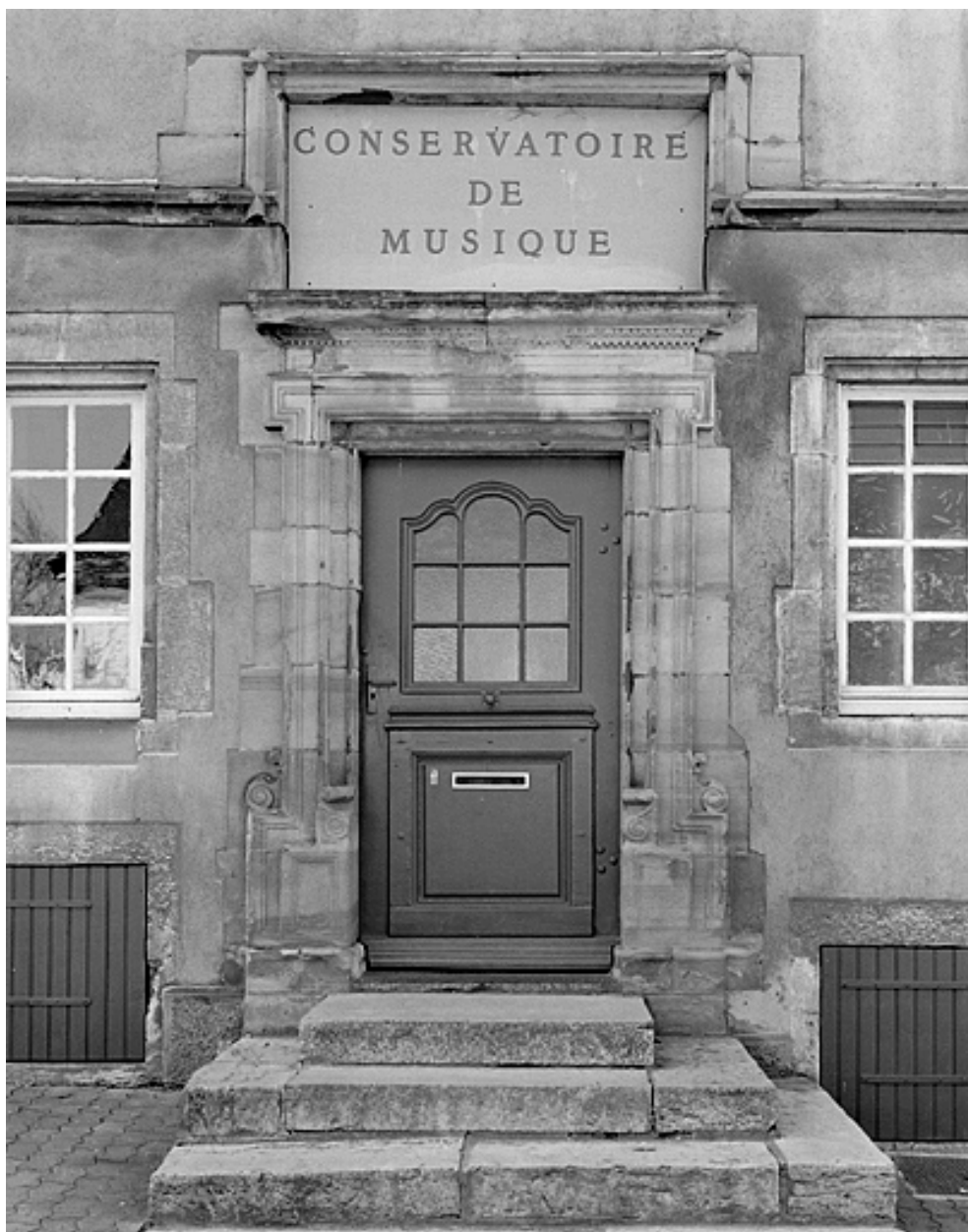
Façade principale. Porte centrale.
