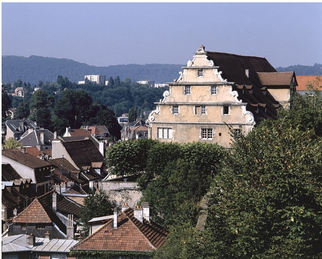
Façade latérale est.
