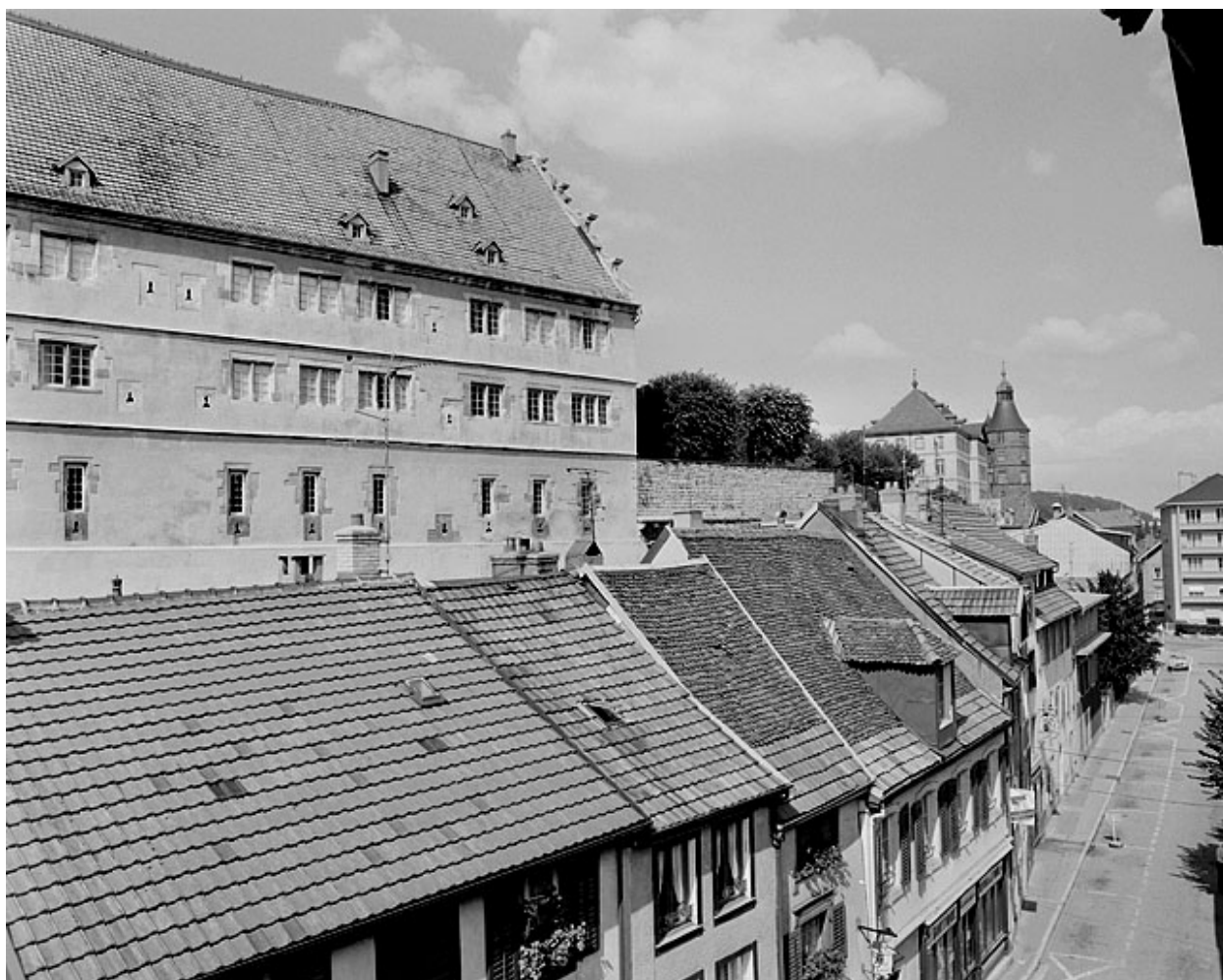
Façade sud et rue de Belfort.
