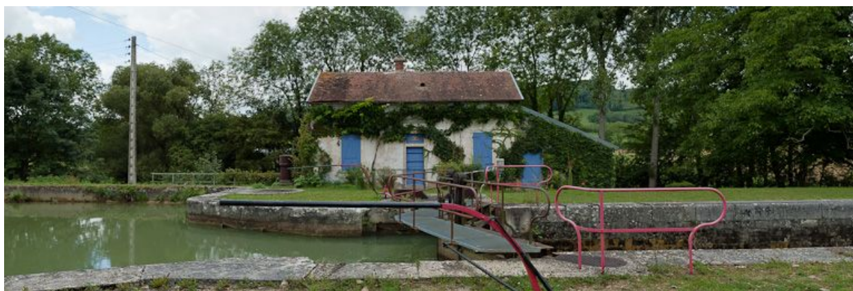
Vue de face de la maison éclusière.
