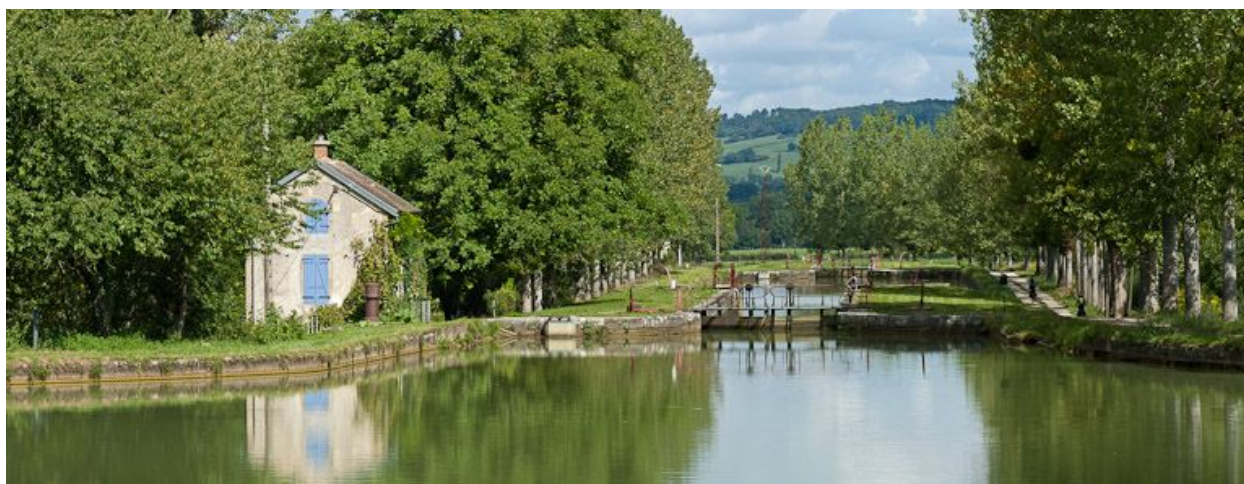
Vue du site d'écluse depuis l'amont.
