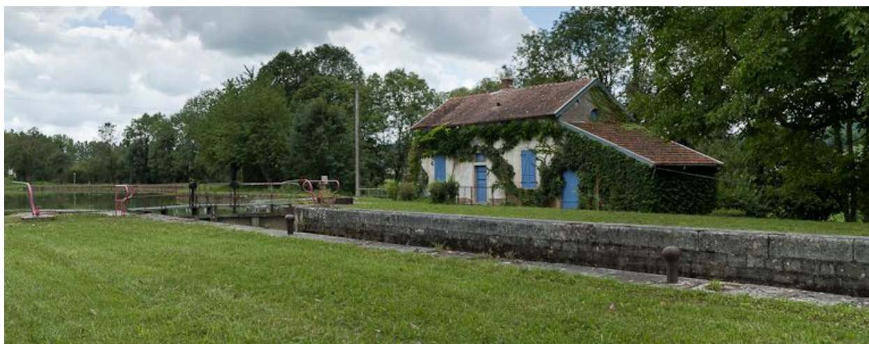
Vue d'ensemble du site d'écluse.
