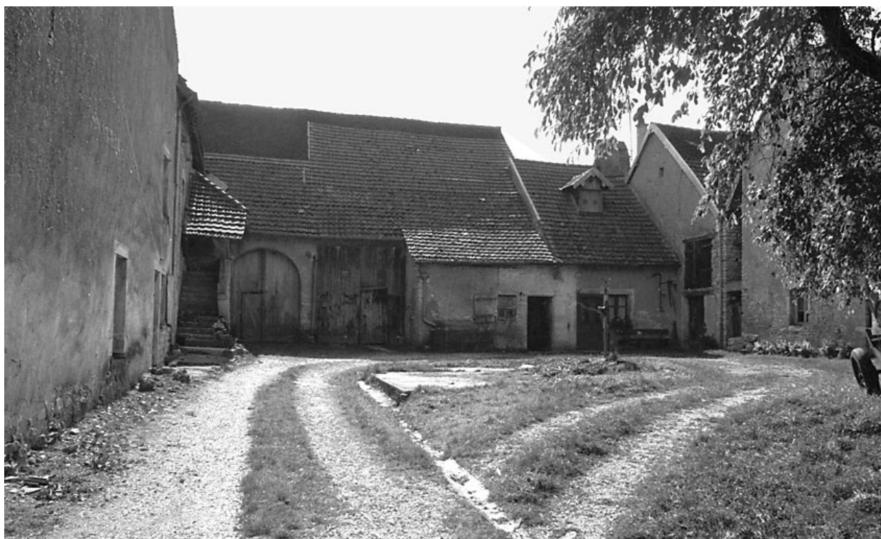
Vue d'ensemble de la partie gauche.
