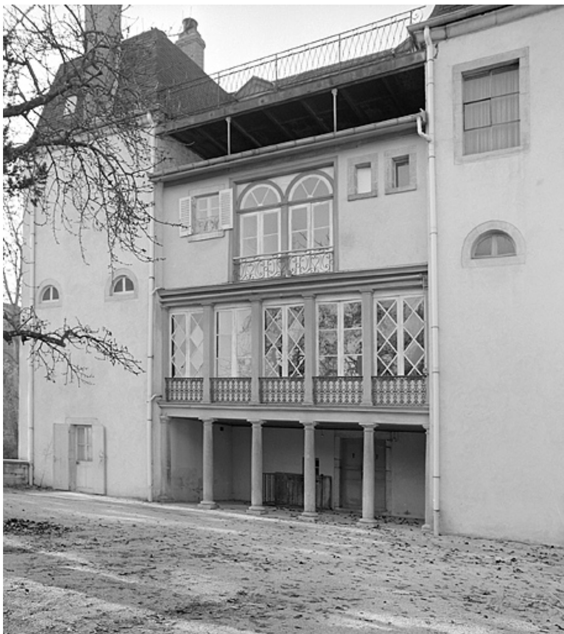
Façade postérieure, détail.
