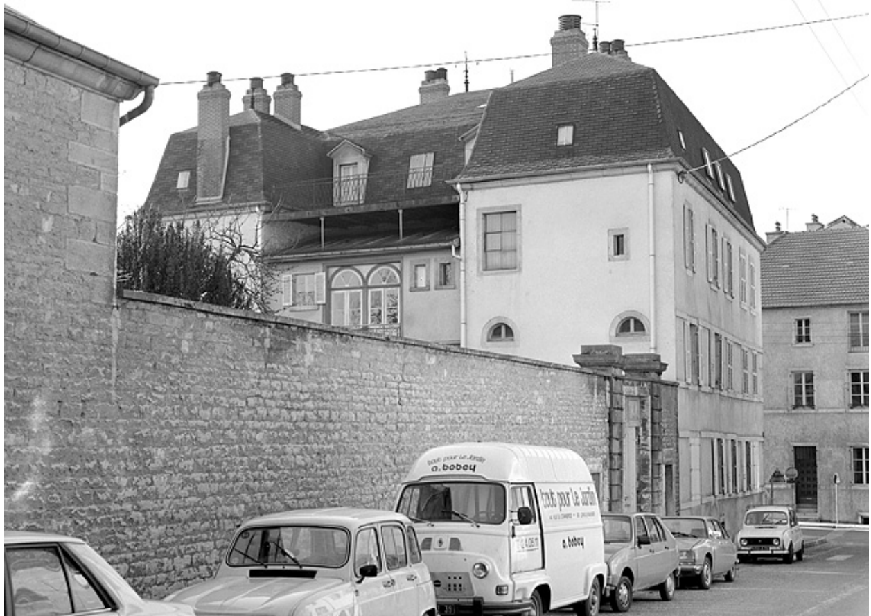
Façades postérieure et latérale gauche.
