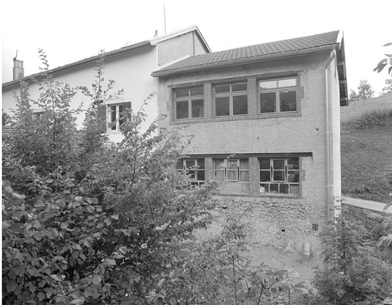
L'atelier de tournerie accolé à la ferme.
