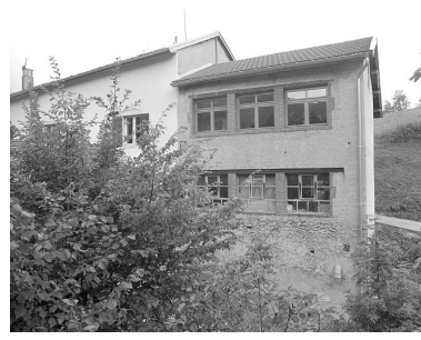
L'atelier de tournerie accolé à la ferme. Phot. Jérôme Mongreville IVR43_19963901422X
