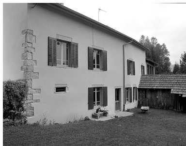
Façade antérieure de la ferme. Phot. Jérôme Mongreville IVR43_19963901418X
