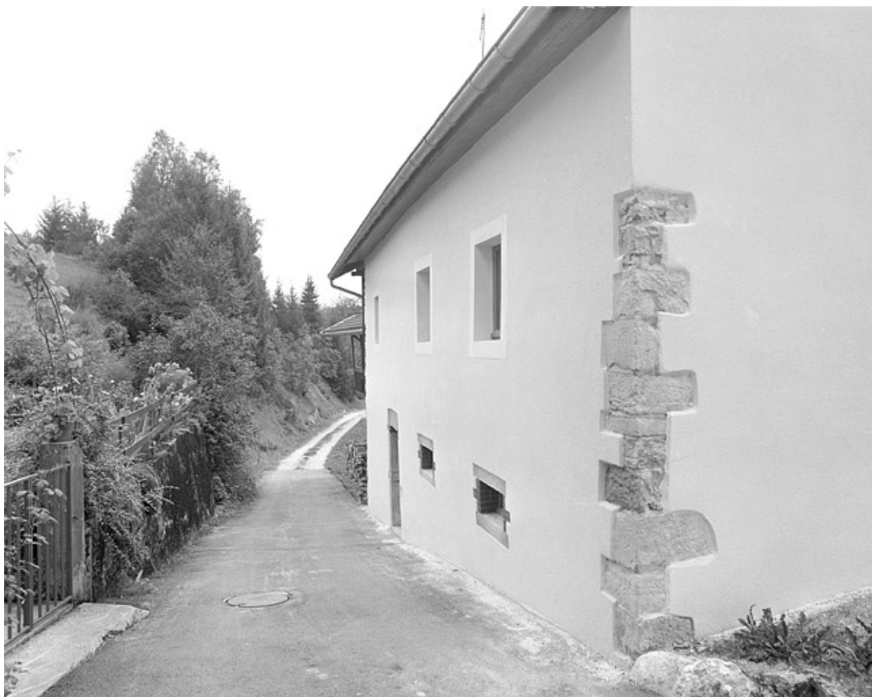
Façade postérieure de la ferme, ancienne étable.
