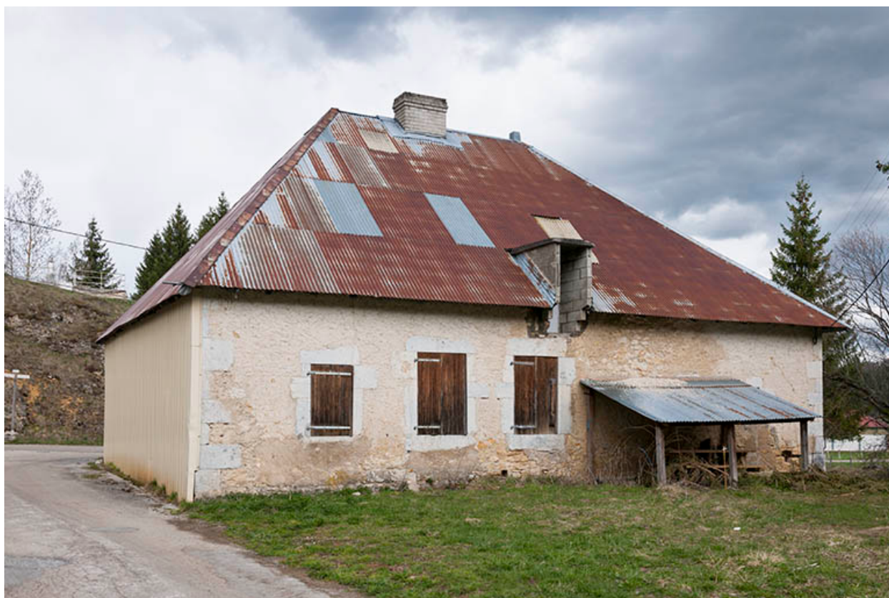
Façades postérieure et latérale droite en 2016.
