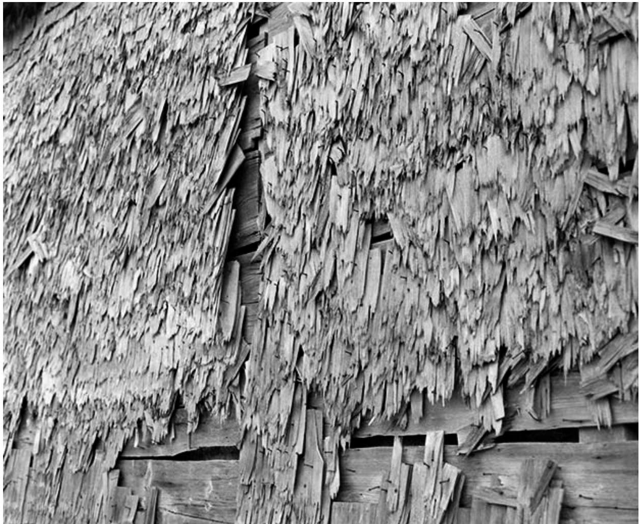
Tavillons de la façade latérale droite en 1978.
