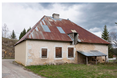
Façades postérieure et latérale droite en 2016.
