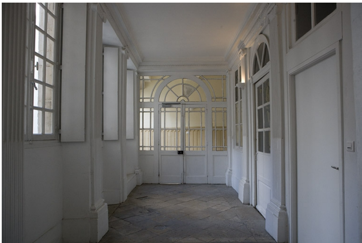
Vue d'ensemble du vestibule.
