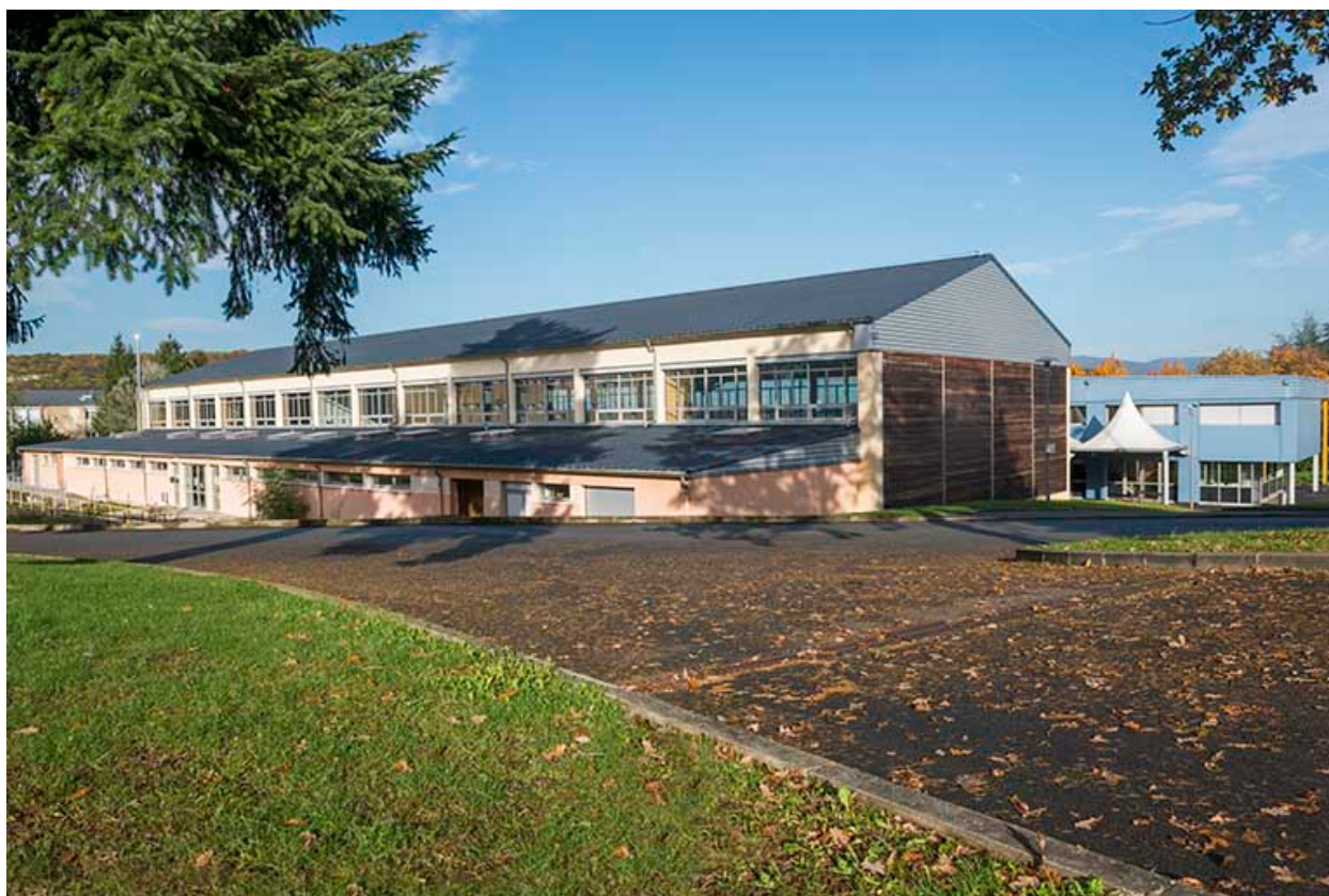
Angle sud-est du gymnase.
