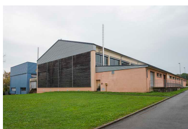
Angles sud-ouest du gymnase et de l'atelier de logistique. Phot. Mary Ruffinoni IVR43_20139000050NUC4A
