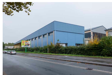
Façade nord et angle nord- ouest du pôle logistique et pignon ouest du gymnase. Phot. Mary Ruffinoni IVR43_20139000047NUC4A
