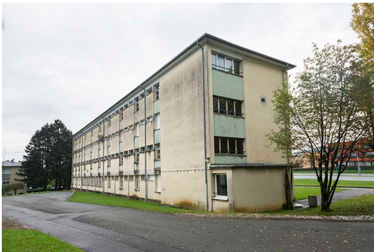
Angle sud-ouest de l'internat de garçons ouest.
