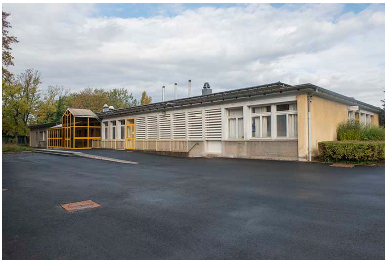
Angle sud-est de la restauration.
